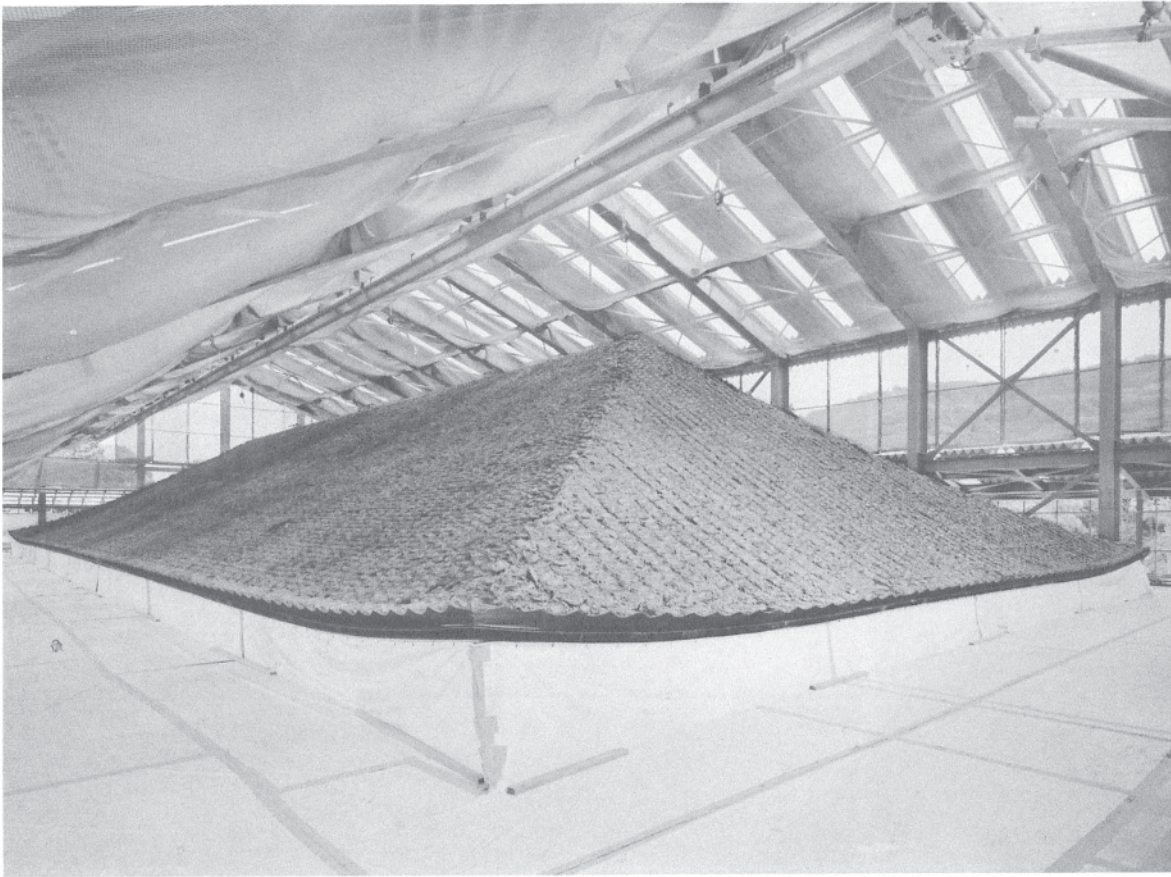
77 南面及び西面の平瓦葺土の状況 西南より見る。西面には大正修理での補足瓦が南から葺かれており、丸瓦同様の葺土の違いが見られた。
