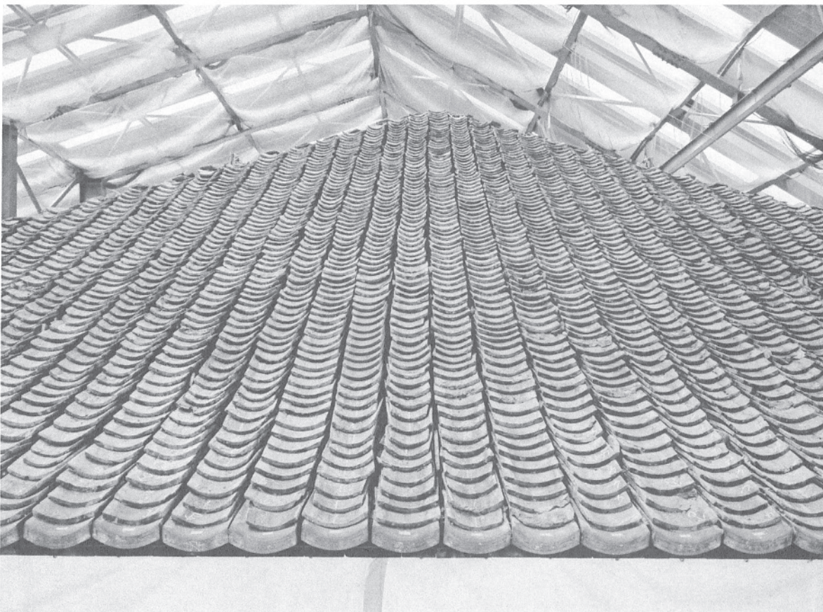
76 北面の平瓦の状況
