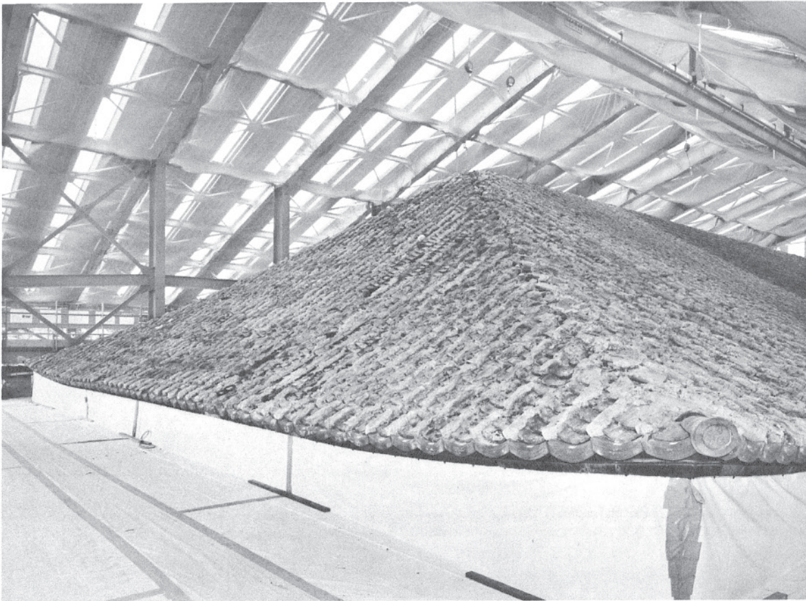
71 北面の丸瓦葺土の状況 西北より見る。最も多く営巢の状況が見られた面である。
