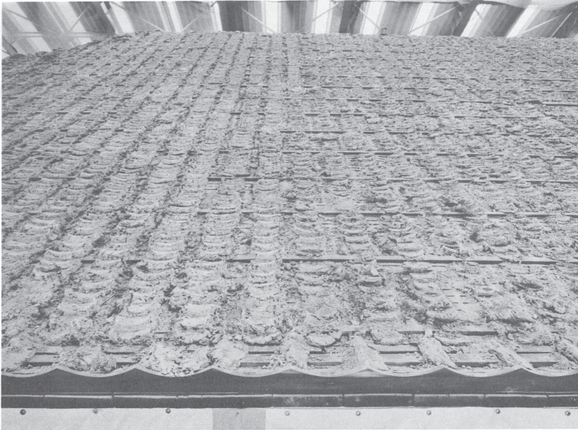
79 西面北寄りの平瓦葺土の状況
