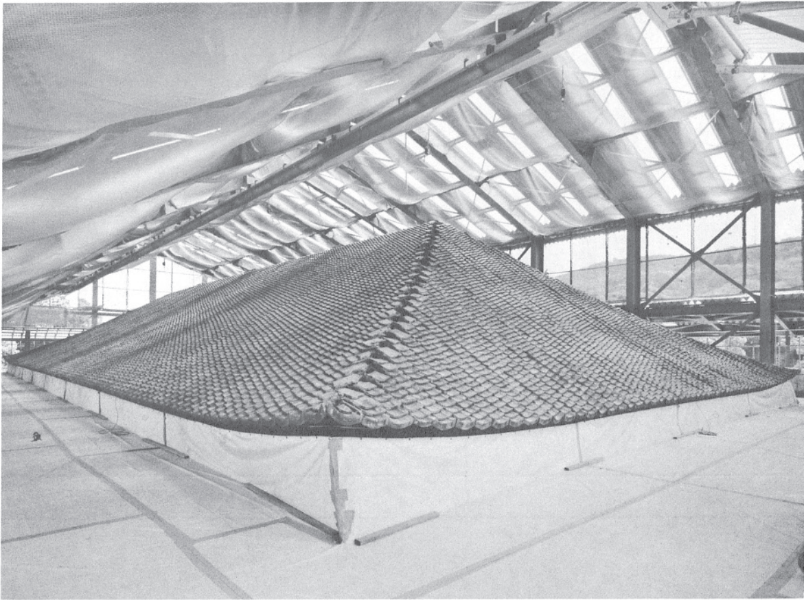
73 南面及び西面の平瓦の状況 西南より見る。
