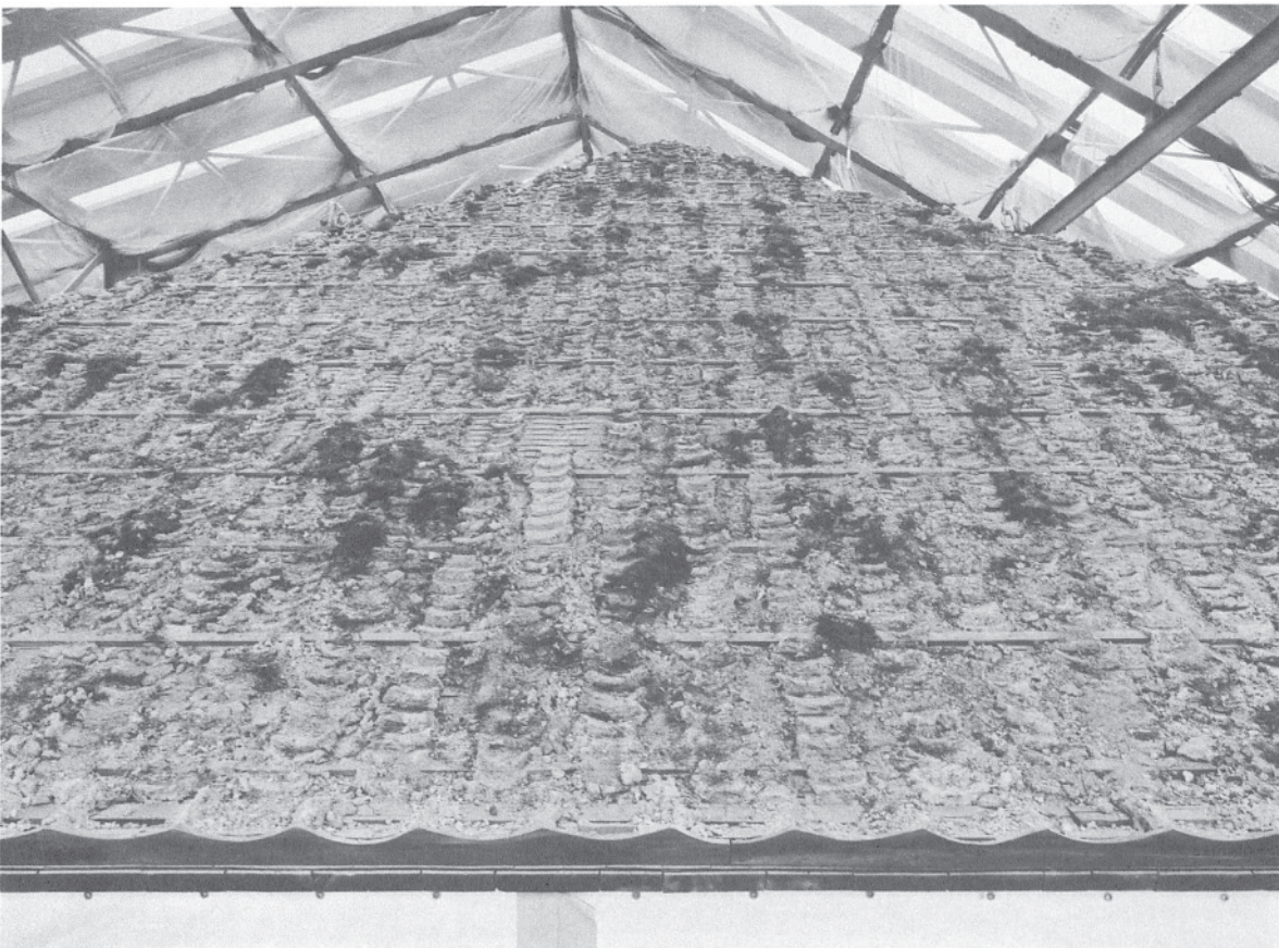
80 北面の平瓦葺土の状況
