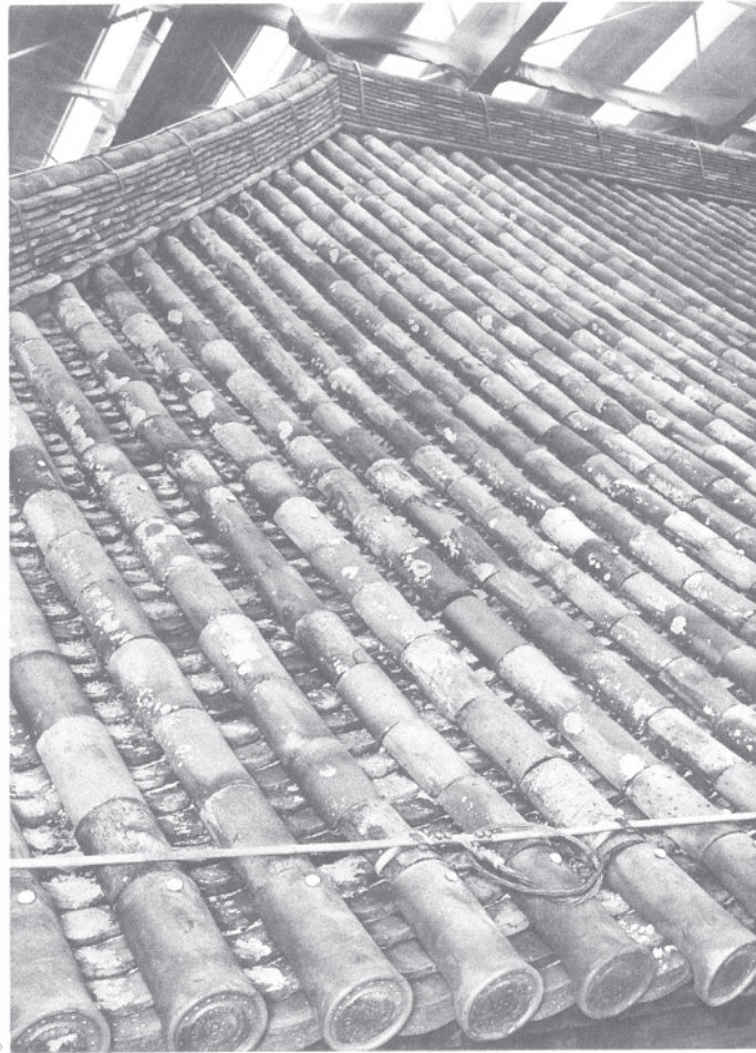
53 修理前本瓦葺西面詳細 西面北寄りの修理前本瓦葺を西より見る。
