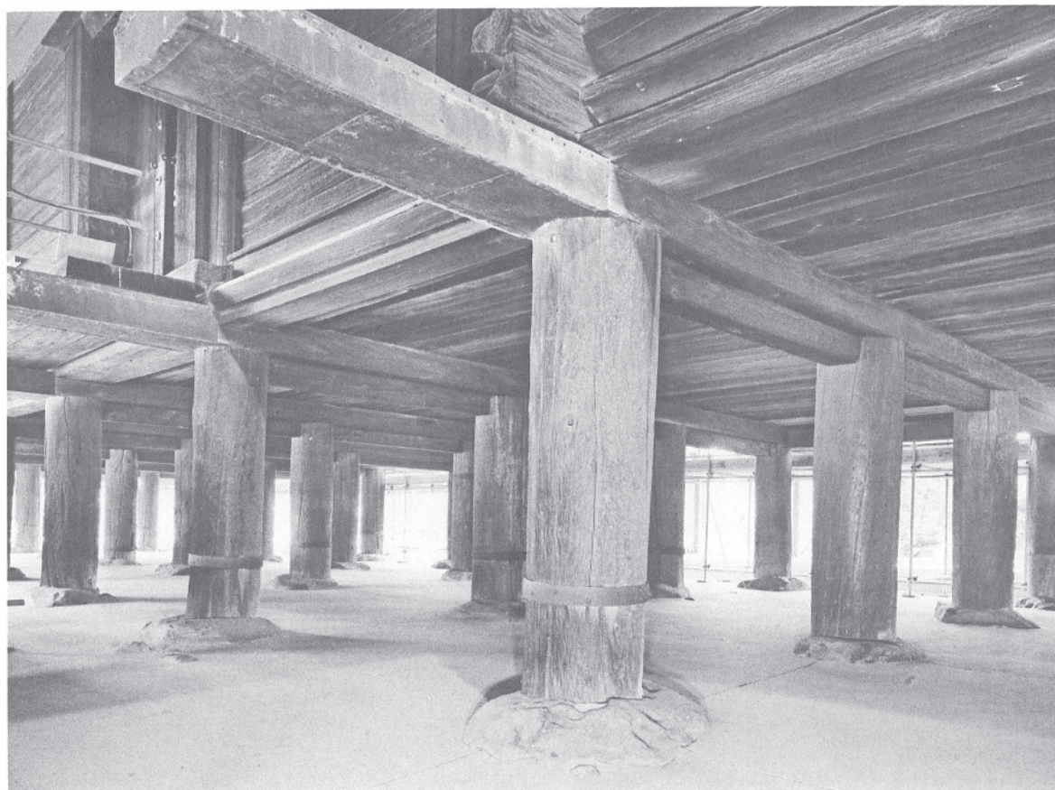
46 修理前床下束柱中倉下
