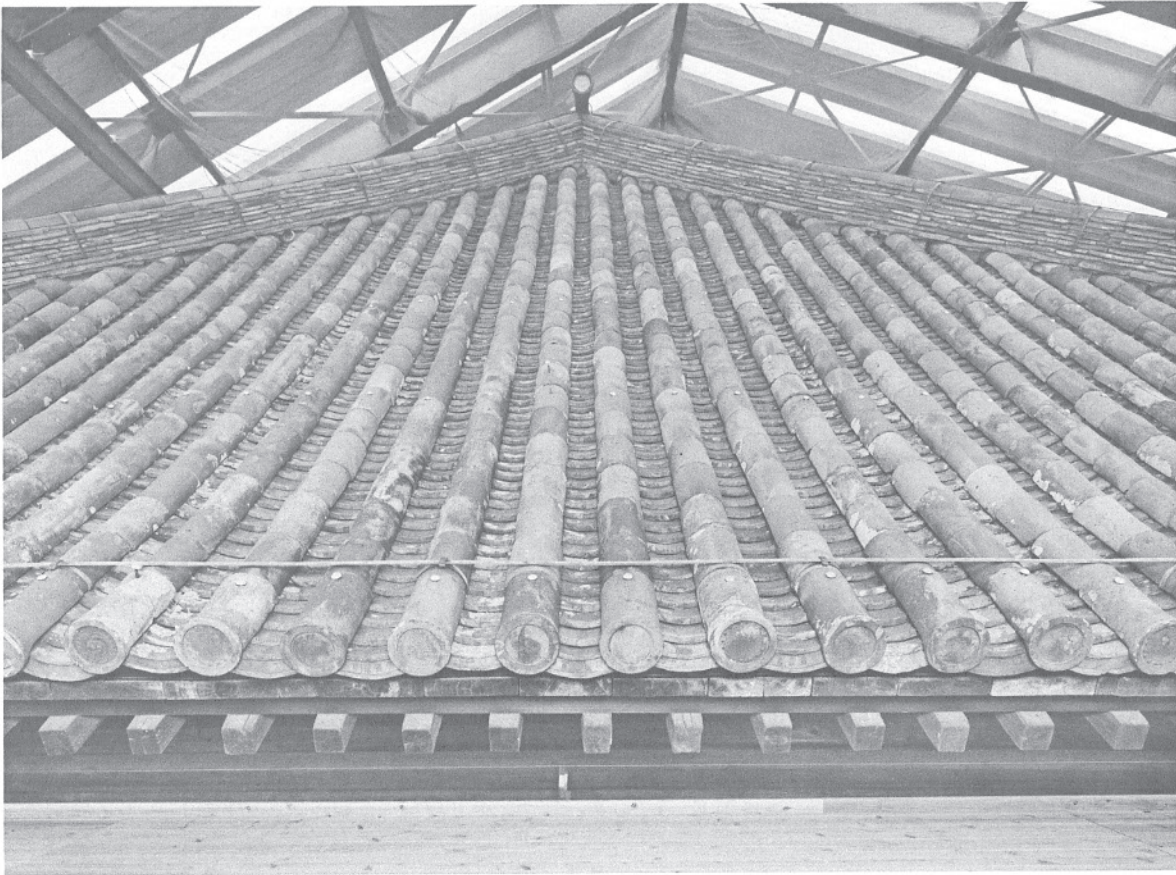
49 修理前本瓦葺南面詳細 南面の本瓦葺修理前をまっすぐ南から見た詳細。妻面は、平瓦が真に来るように割り付けられていた。
