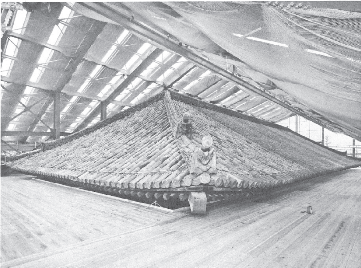
52 修理前本瓦葺北面及び西面 西北より北面と西面の本瓦葺修理前の状況を見る。
