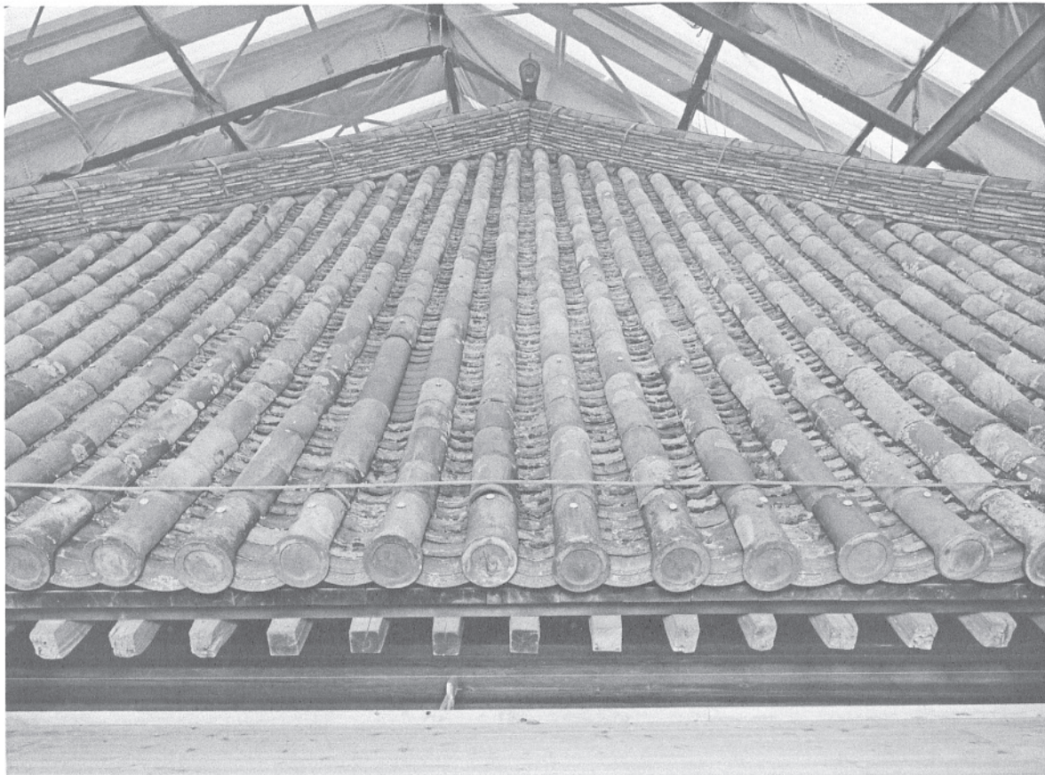
50 修理前本瓦葺北面詳細 北面の本瓦葺修理前をまっすぐ北から見た詳細。
