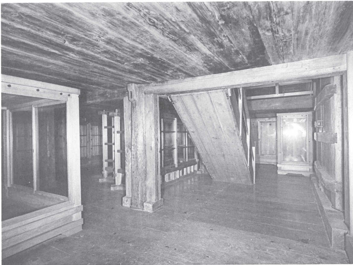
39 修理前北倉内部一階北面 東南より北倉一階のガラス戸付陳列棚を見る。
