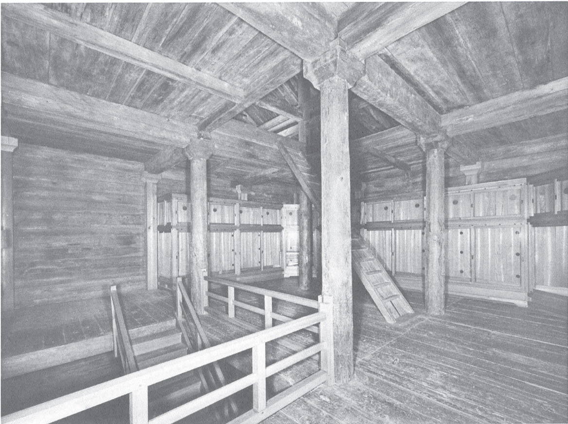
42 修理前北倉内部二階南面及び西面 東北より見る。中央間には南へ向かって梯子段がかかり、小屋裏へ上がれるようになっている。
