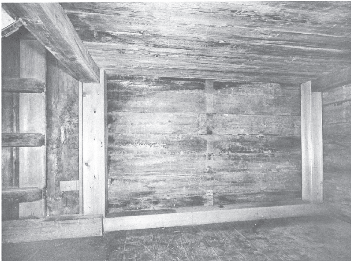
40 修理前北倉内部一階東面南寄りの壁面 西より見る。建長六年の落雷による火災の跡と思われる焦げ跡が残る。両脇の内部柱と土台は大正期の修理材である。
