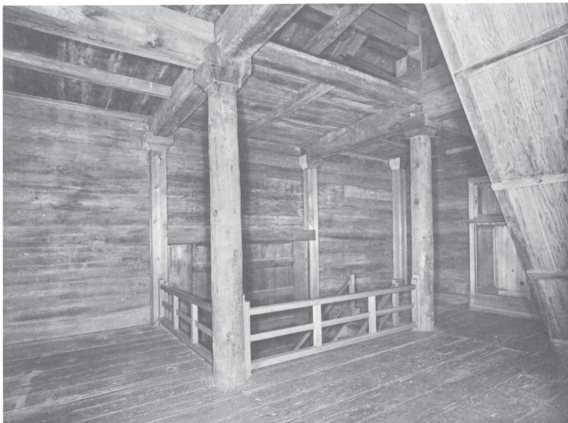
33 修理前南倉内部二階東面 西北より見る。落下防止用の手摺りも大正修理後のものである。
