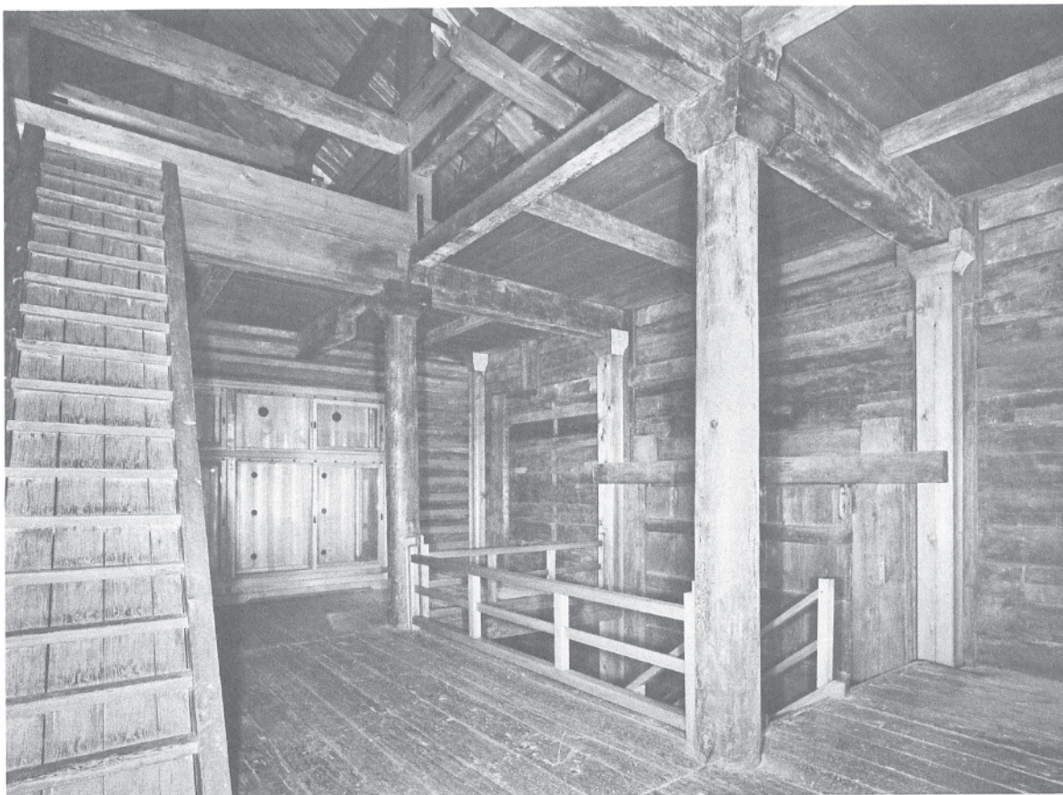
37 修理前中倉内部二階北面及び東面 西南より見る。隅（写真奥）と壁際の大梁下に見える内部柱は、大正修理時に取り替えた柱である。
