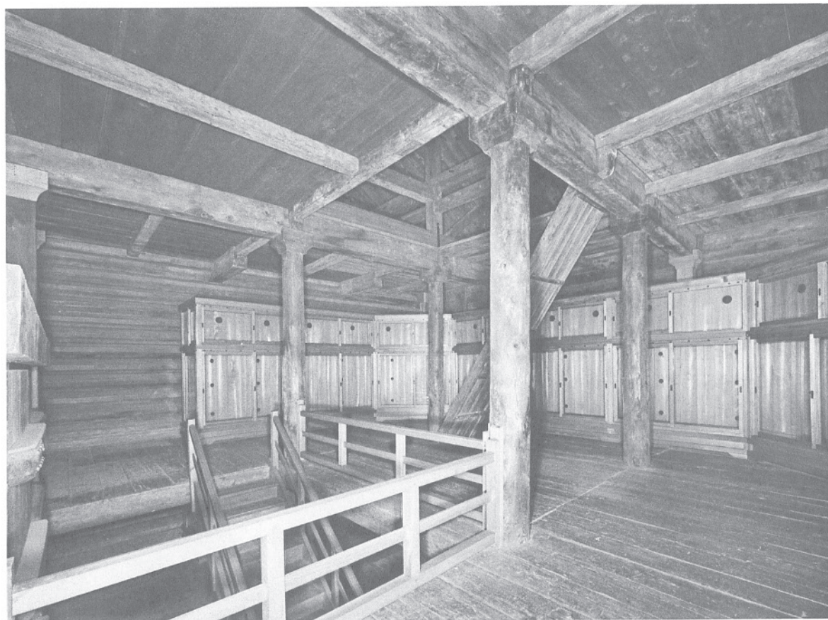
38 修理前中倉内部二階南面及び西面 東北より見る。南・西・北の壁面に明治期に作り付けられたガラス戸付陳列棚がある。
