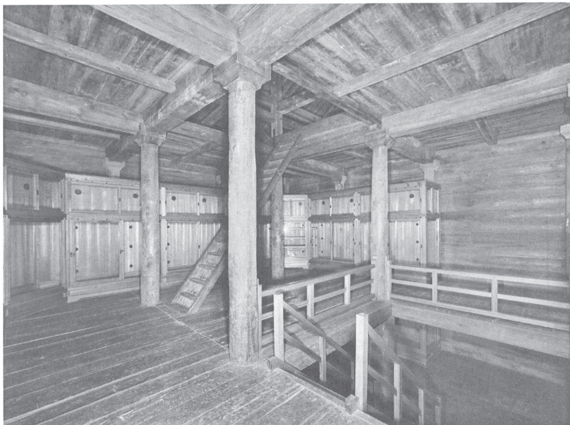
34 修理前南倉内部二階西面及び北面 東南より見る。二階には二段のガラス戸付陳列棚が置かれ、中央間には北へ向かって小屋裏へ上がる梯子段がかかる。
