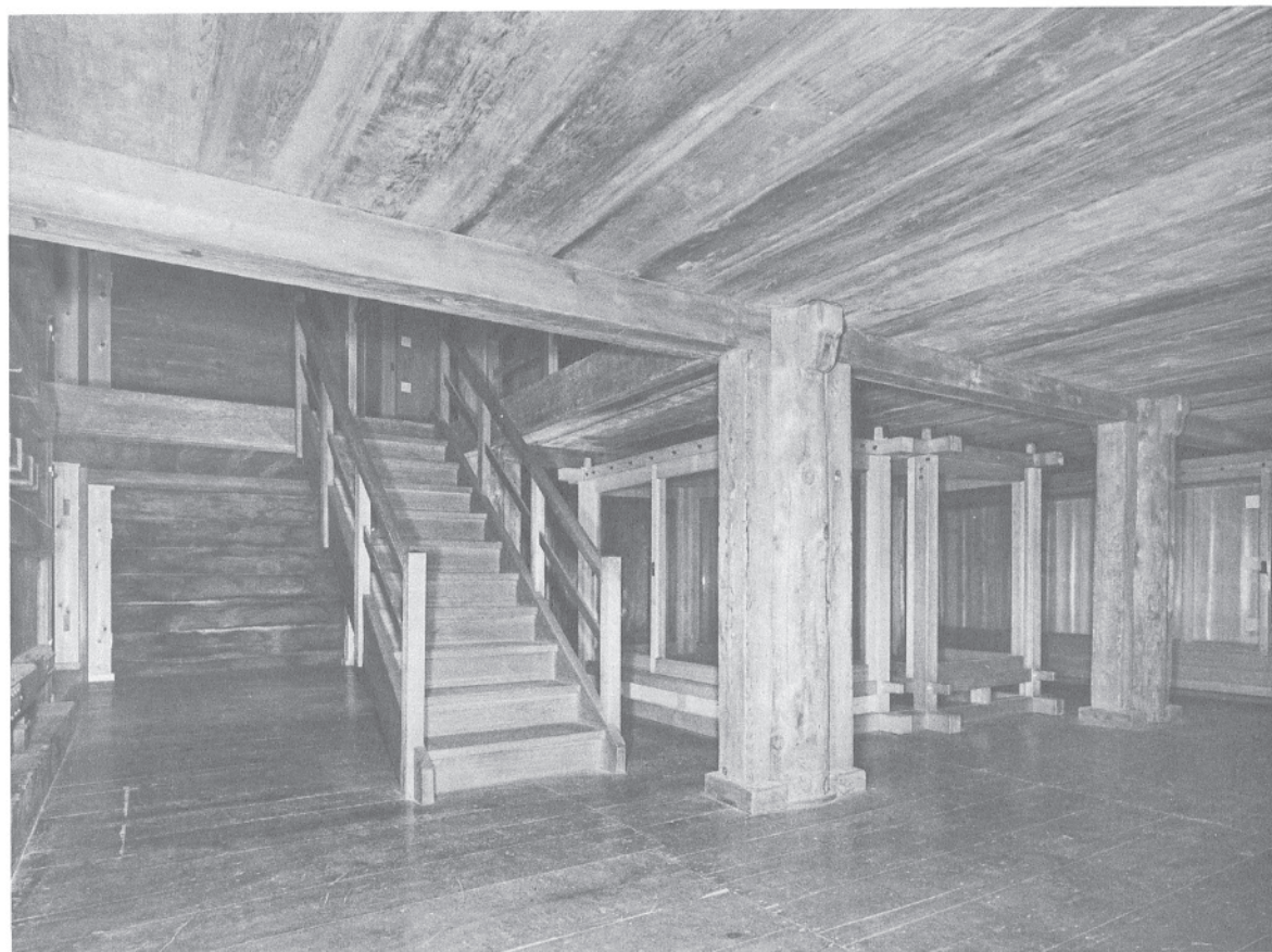
10 竣工南倉内部一階南面及び西面
