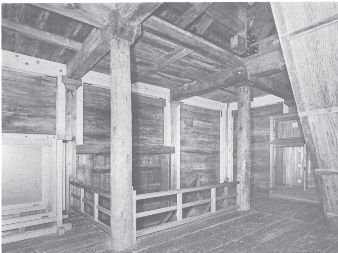
11 竣工南倉内部二階東面 西北より見た南倉二階の東面。敷桁を補強するために入れた受け材と支持柱の様子がよくわかる。
