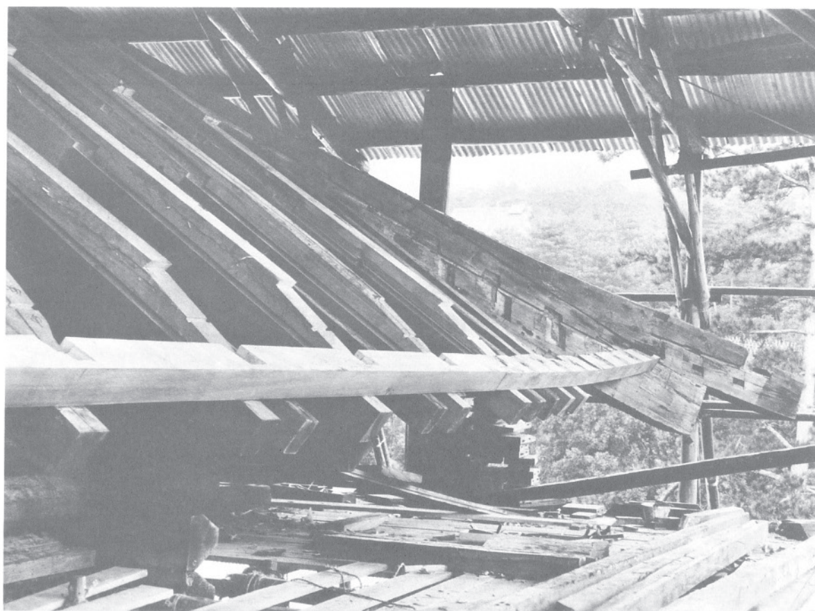
204 大正修理時の木負取り付け状況
