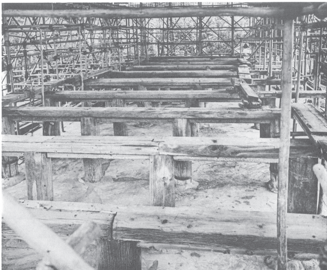
191 大正修理時の束柱及び台輪の組立状況
