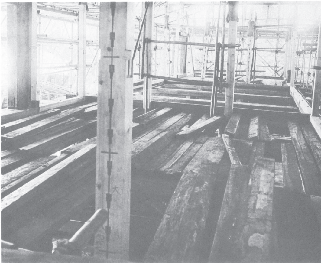
194 大正修理時の土台及び内部柱の組立状況 3
