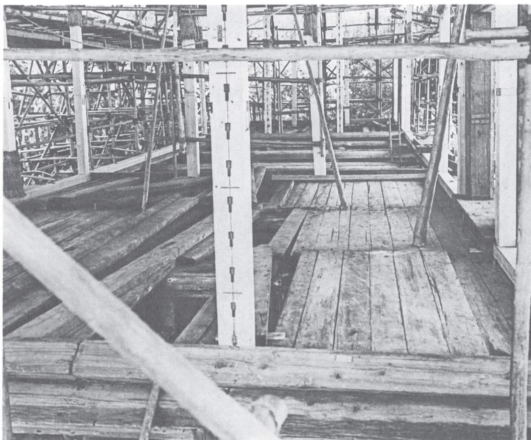
192 大正修理時の土台及び内部柱の組立状況 1
