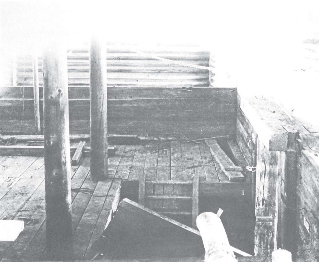
182 大正修理解体中の南倉・中倉境 「第二九号 宝庫南側ヨリ南倉入口中倉北倉校木取解ノ現況」。南倉の校木を扉の上まで解体したところ。中倉の羽目板は既に解体され、奥には北倉の校木が見える。
