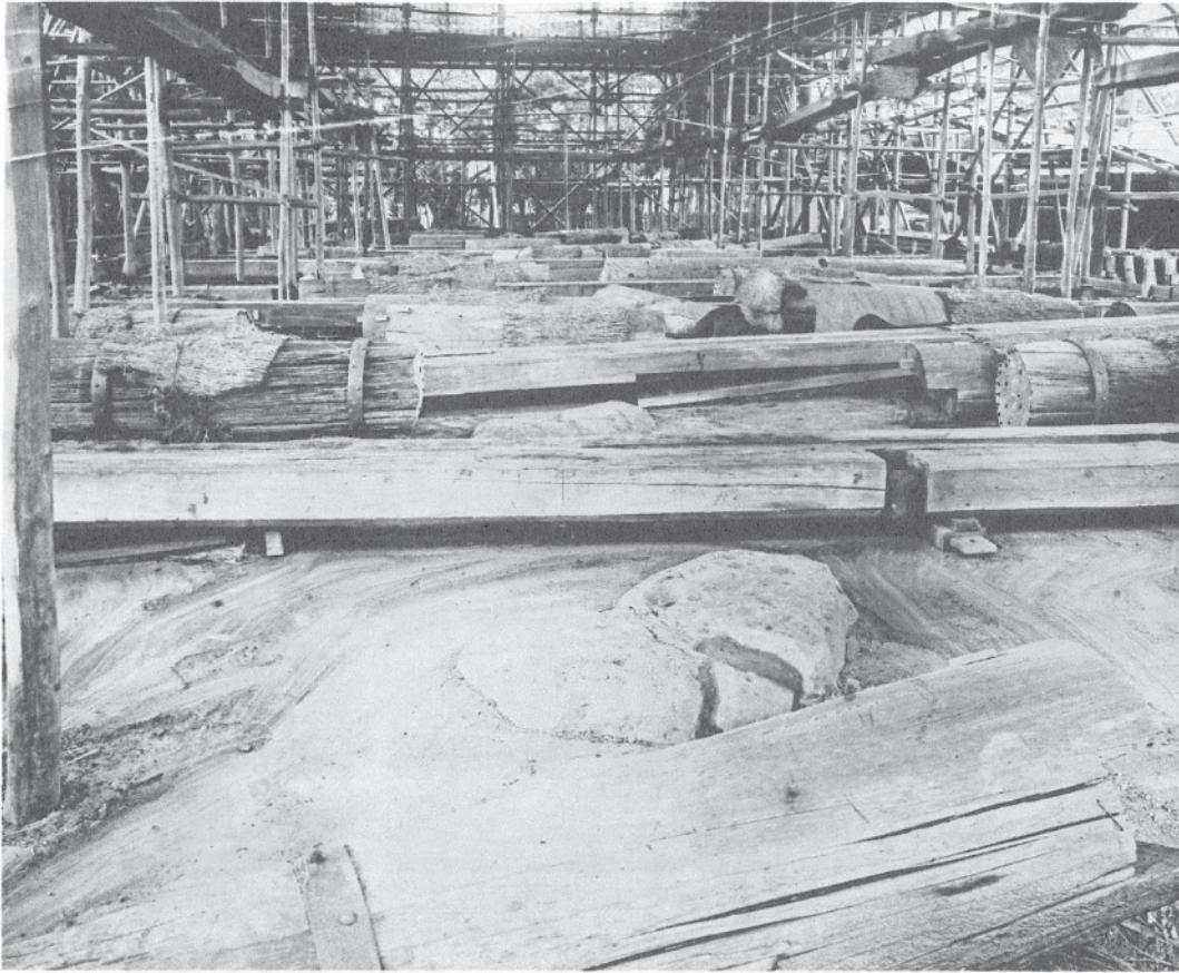
187 大正修理時の東柱解体状況 「第三四号 宝庫北倉北側ヨリ床下大枿取解方現況」。東柱まで解体した状況。
