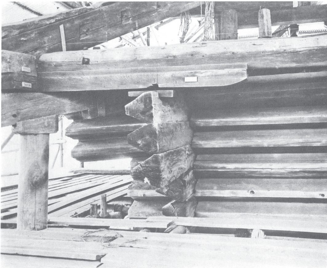
180 大正修理解体前の丸桁西北隅部詳細
