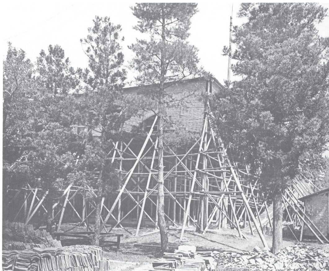
174 大正修理時の素屋根 「第二一号 宝庫東南隅ヨリ上家足代架設出来現況」。素屋根は丸太で組まれ、軒からは筵が下げられている。右側に登棧橋が設置されている様子も分かる。
