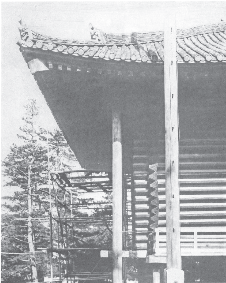
167 大正修理前南倉東面南端 「第一四号 宝庫南倉東側南角軒先及校木組手現況」。南面に足場が組まれている。修理前の東南隅棟の様子が見て取れる。東から見る。
