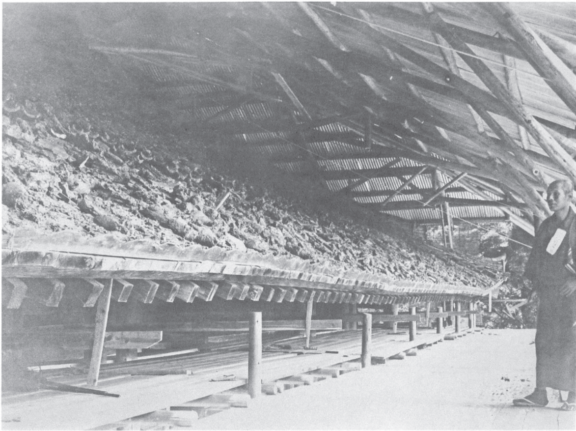
169 大正修理時瓦解体中の東面北方の軒先の状態 「第一六号 宝庫東側軒先廻ノ狂タル現況（北方）」。これが北を見た状態だとすると、素屋根も寄棟造で作られたことがわかる。
