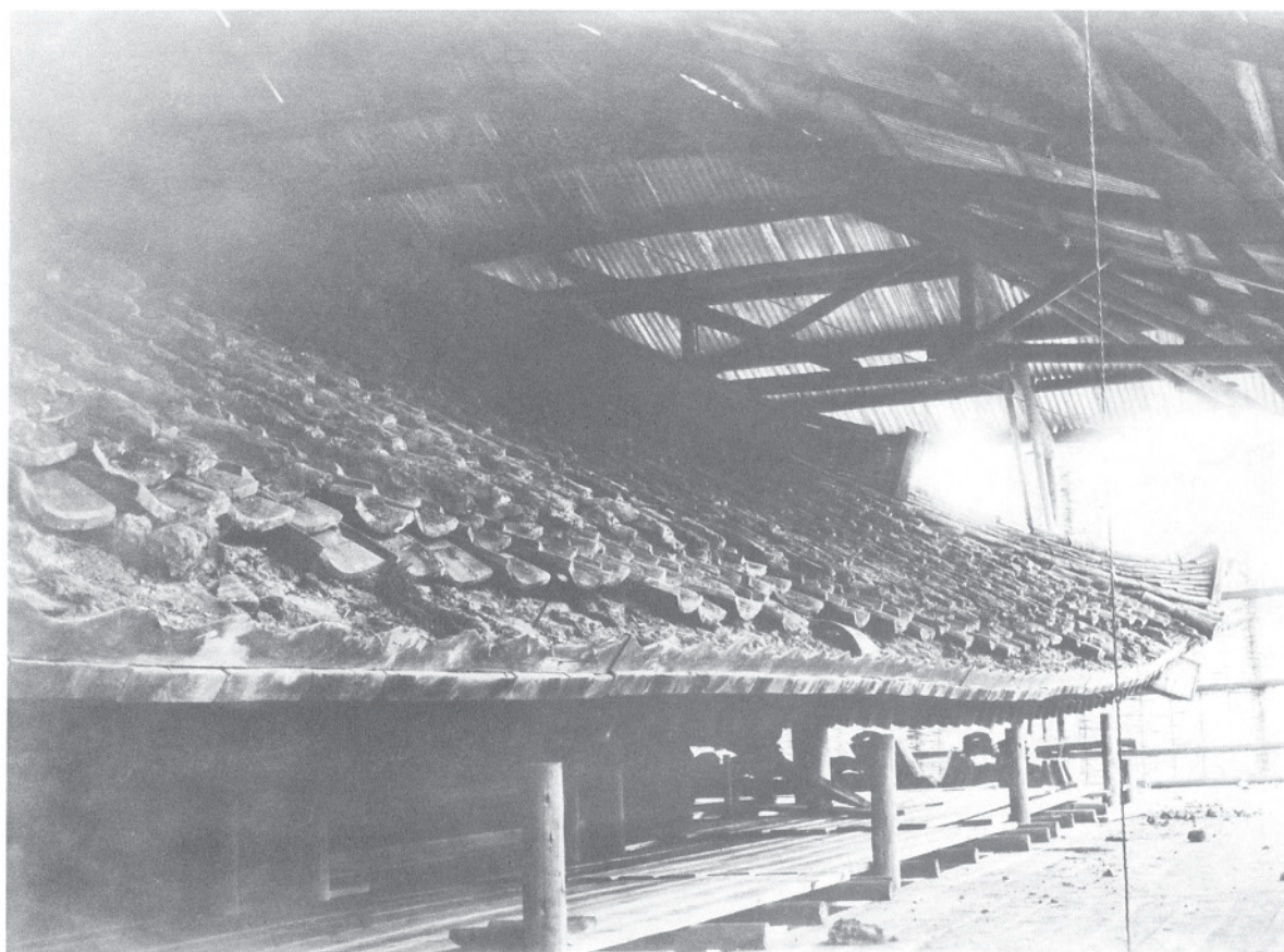
172 大正修理時瓦解体中の西面南方の軒先の状態 「第一九号 宝庫西側軒先廻ノ狂タル現況」。
