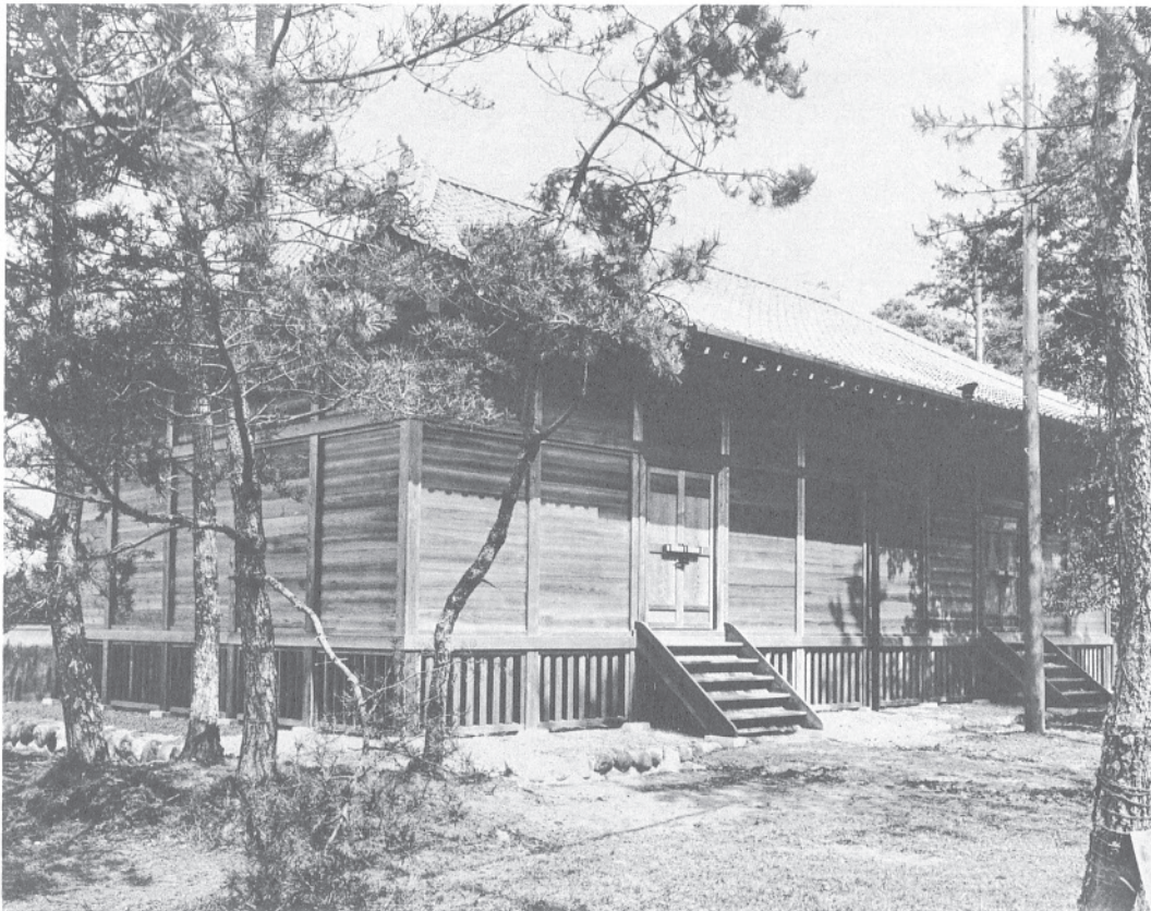
154 大正修理時に建設された仮庫
