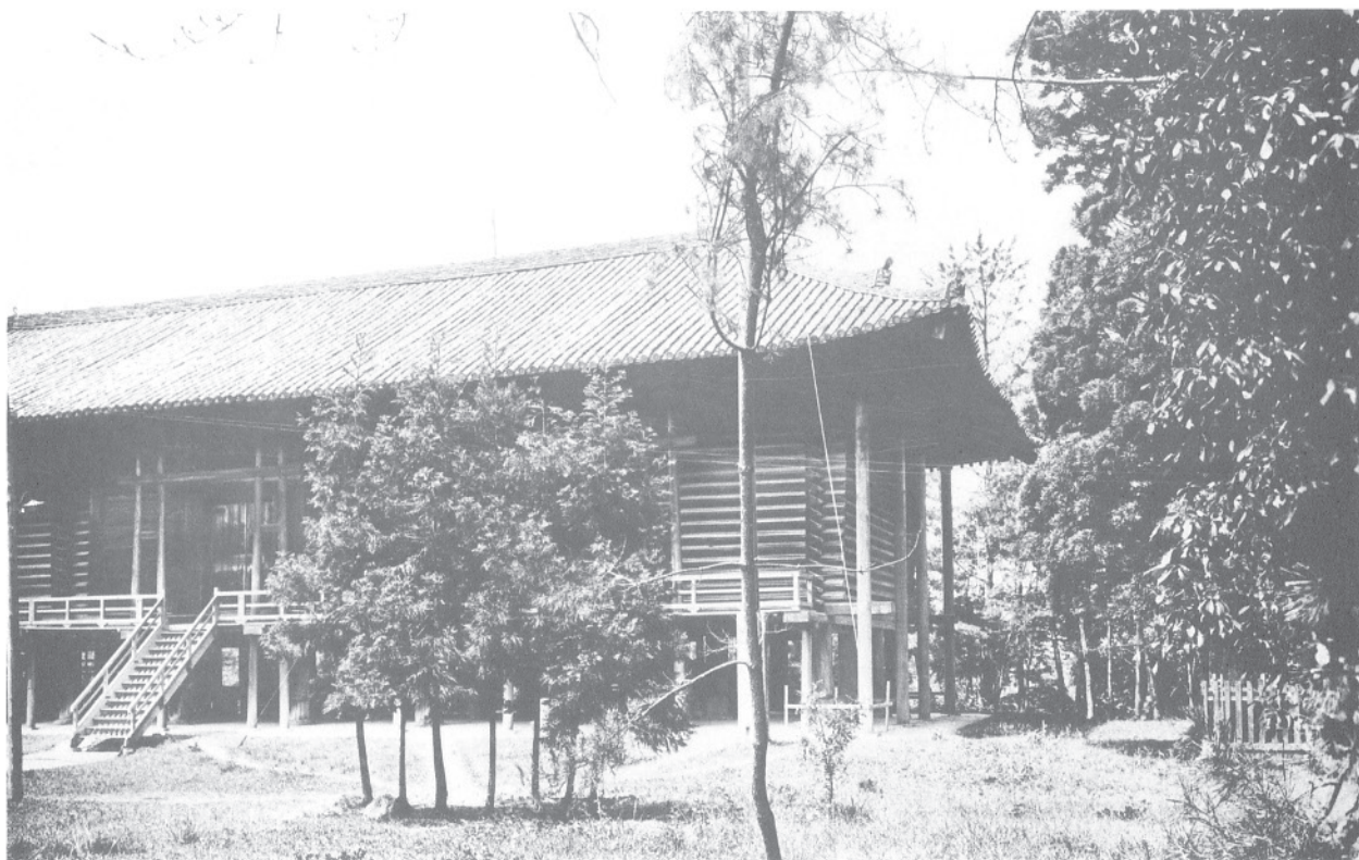
157 大正修理前正側面北寄り（東面及び北面）
