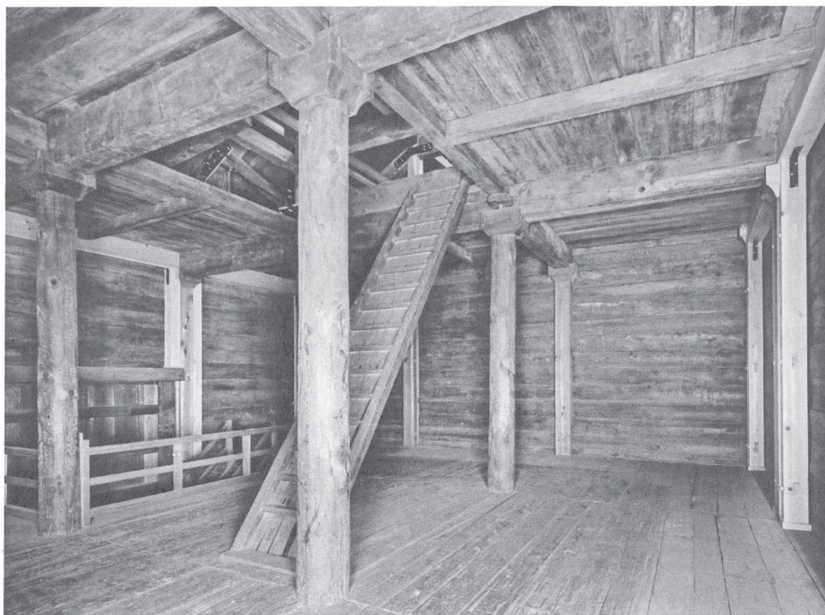
143 敷桁補強後の北倉二階南面及び東面 西北より見る。中倉との境となる南面には支持柱など補加していない。
