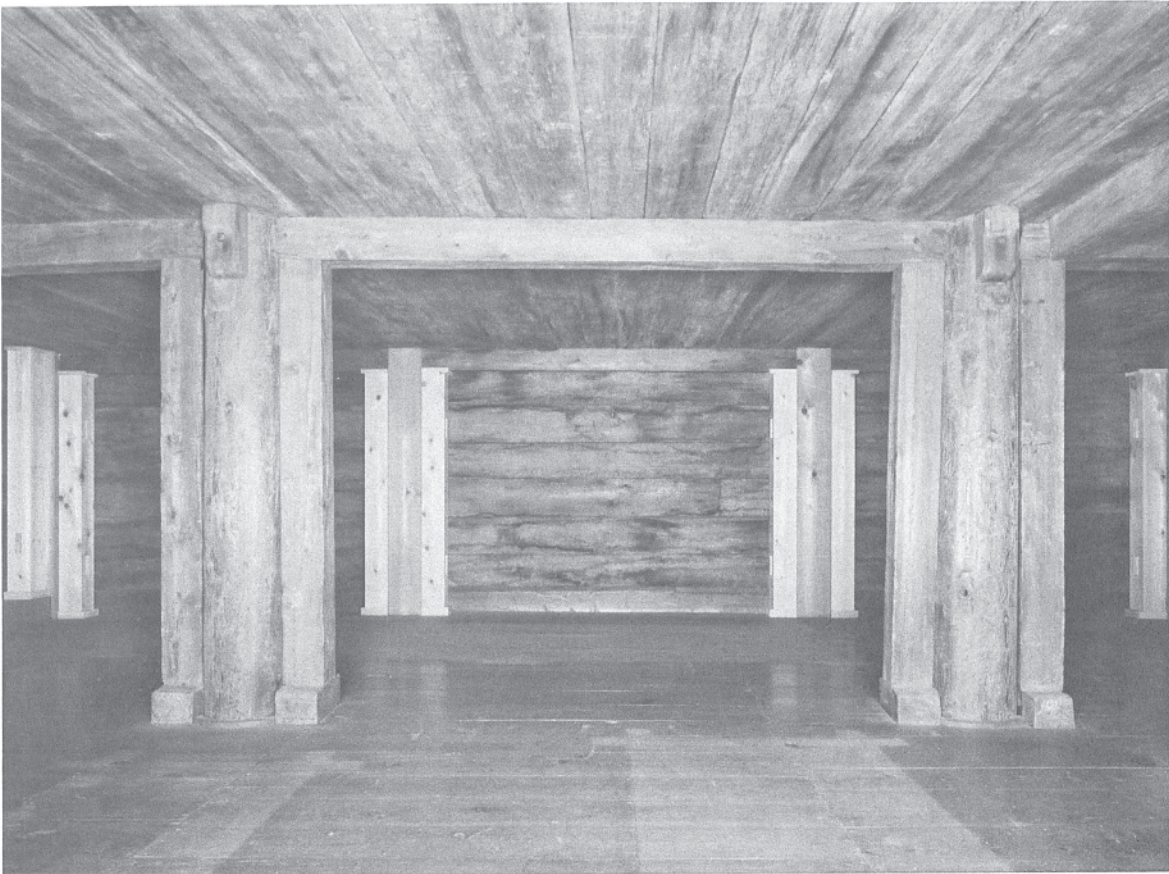
141 敷桁補強後の北倉一階北面 南より見る。南倉同様、敷桁を受けるため、二階に柱を添わせただので、一階にもその柱を支持するため、大正期の内部柱に支持柱を添わせた。
