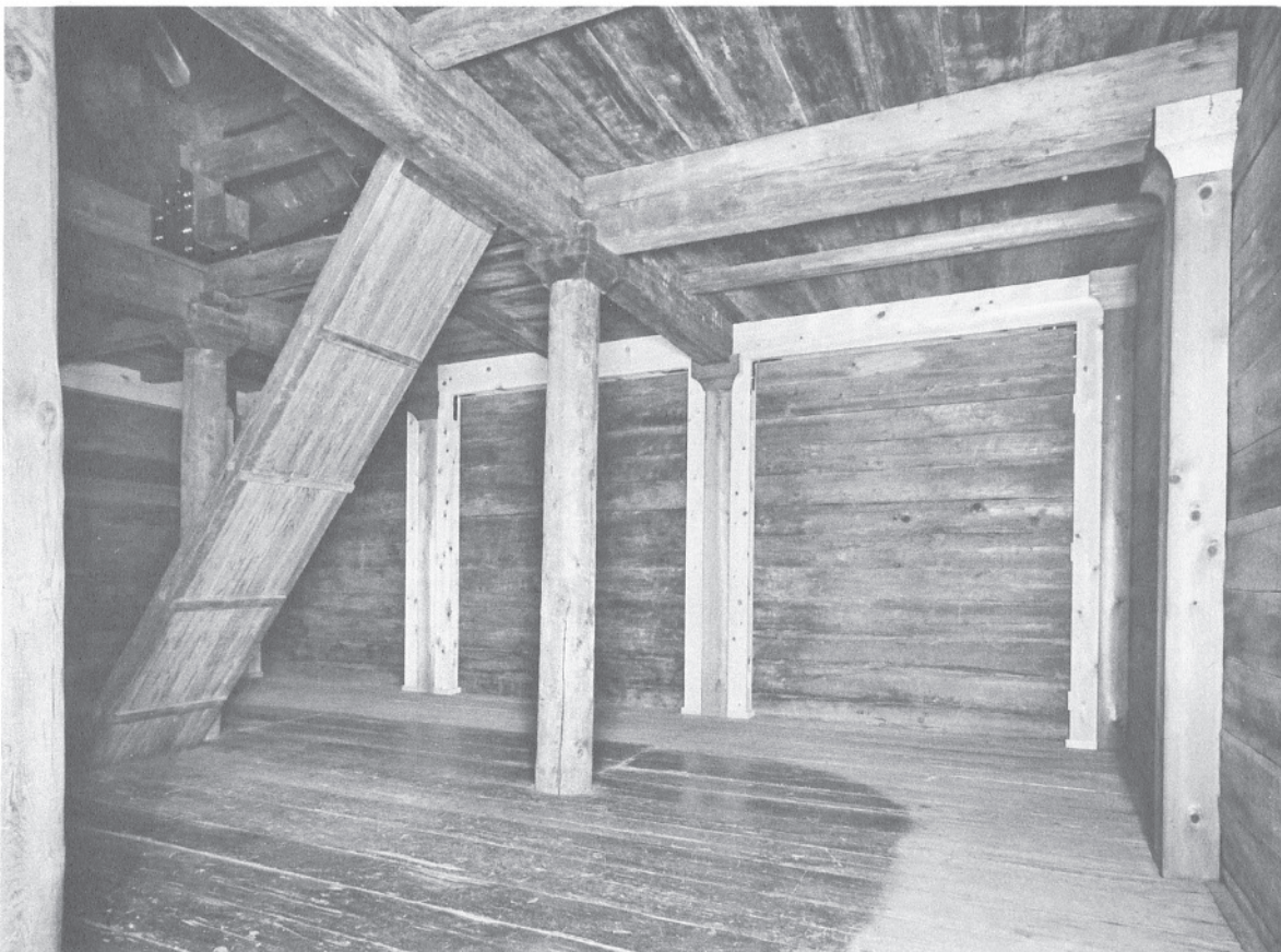
140 敷桁補強後の南倉二階西面 東北より見る。敷桁下に受け材を渡し、大正期に取り替えた内部柱両脇にさらに支持柱を添えて支えた。
