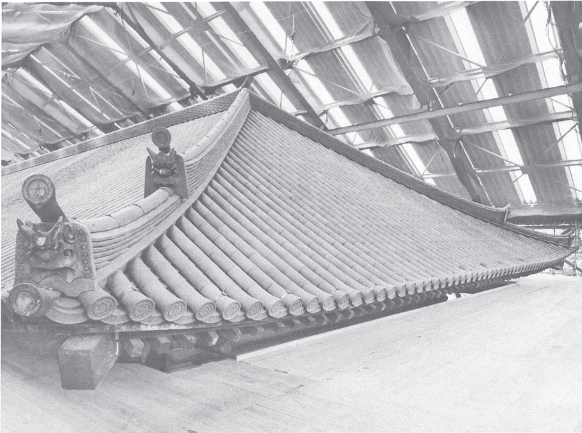
127 北面の本瓦葺葺き上がり
