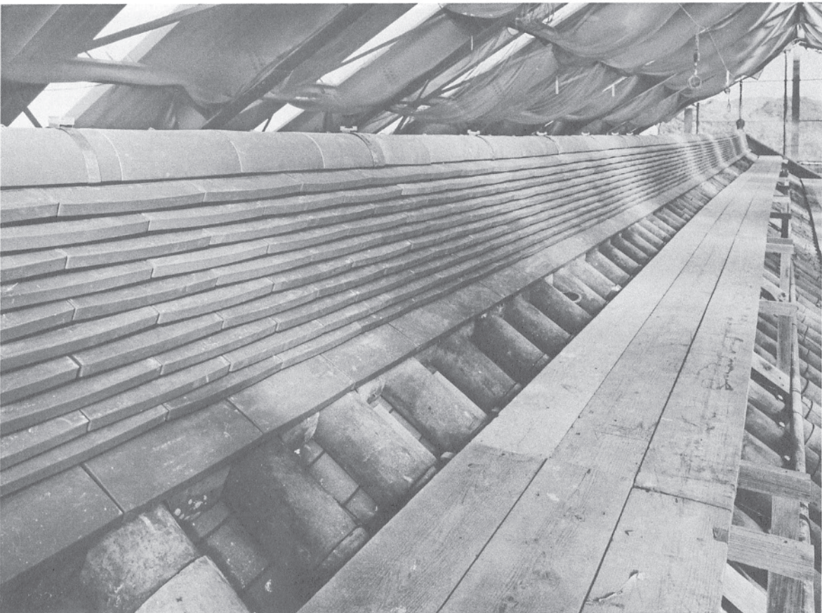
134 大棟棟積完了
