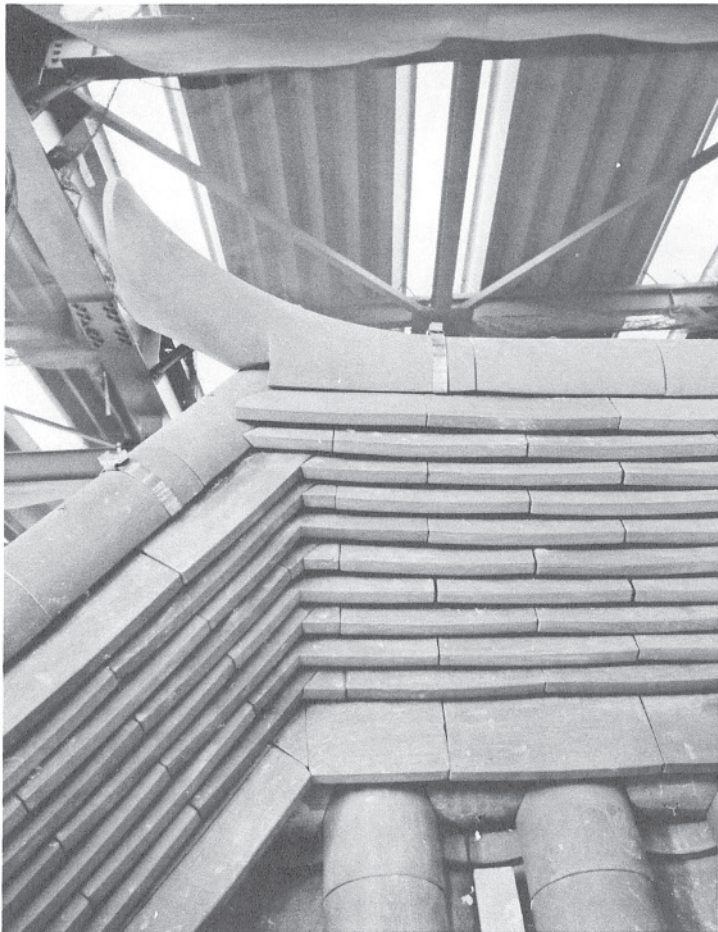
136 大棟棟積完了南端 東より見る。鳥衾瓦は大正二年のものが 載っていたが破損が著しかったため 今回は大正十年の形状に倣い造り替えた。
