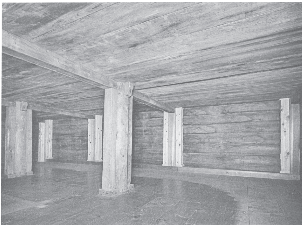
137 敷桁補強後の南倉一階西面
