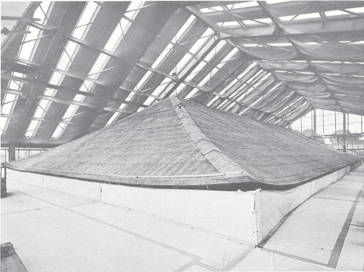
105 南面及び東面の土居葺復旧完了 東南より見る。南面は再用可能な古い土居葺の板を新しい板と葺き混ぜて施工した。棟には銅板も復旧した。
