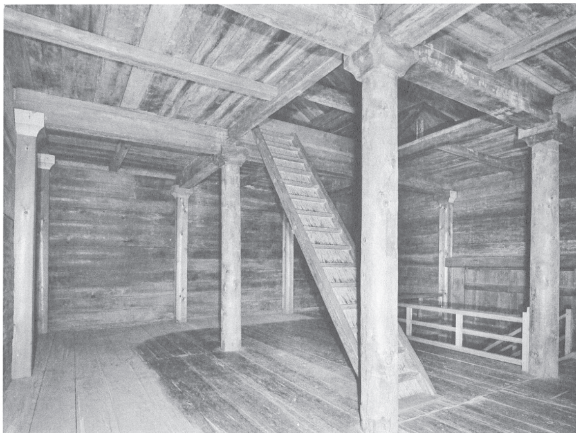
90 ガラス戸付陳列棚解体後の南倉二階北面及び東面 西南より見る。隅と壁際の内部柱は、大正二年の修理で取り替えられたものである。
