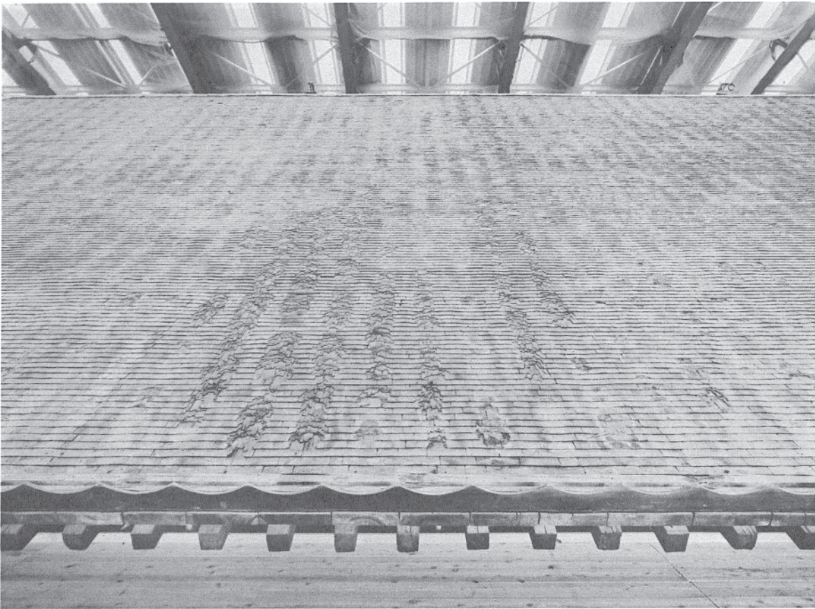
83 西面中央の土居葺の状況
