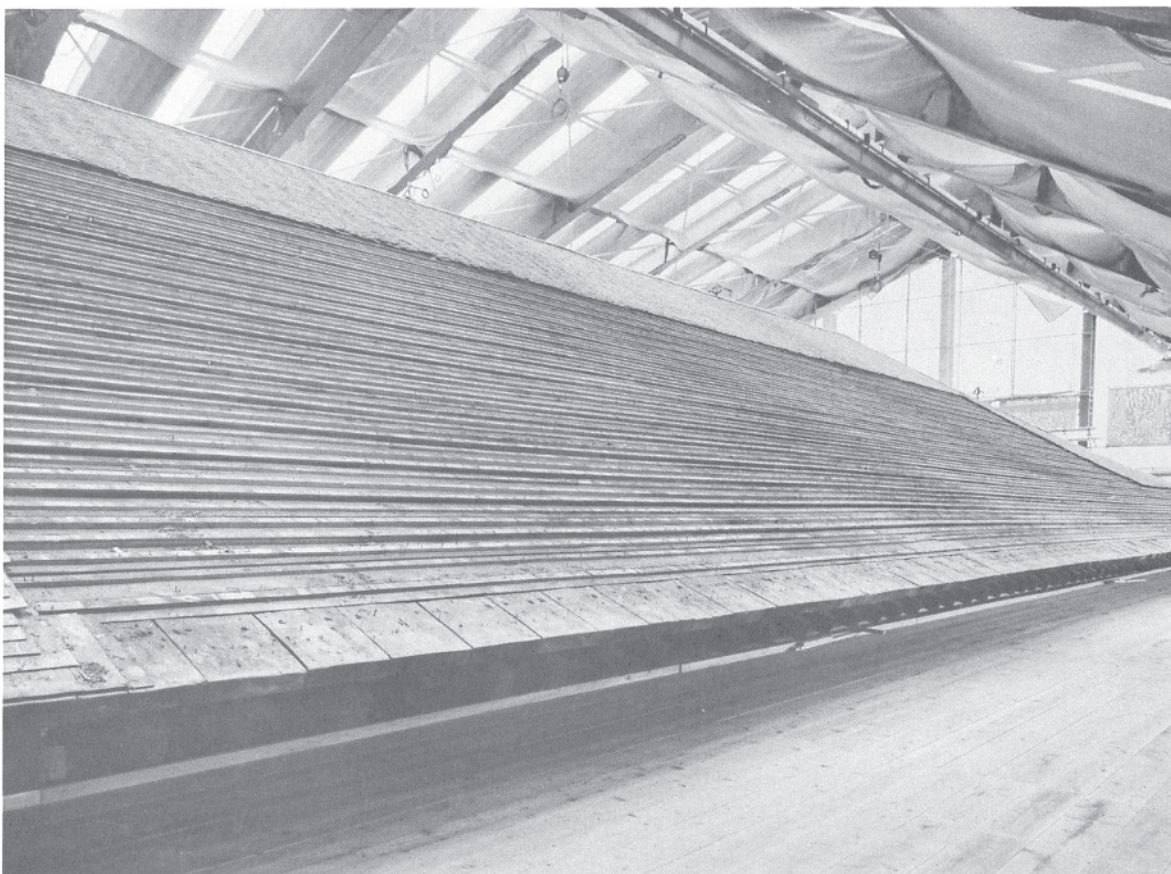
86 西面土居葺解体
