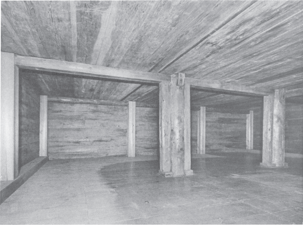
87 ガラス戸付陳列棚解体後の南倉一階北面 西南より見る。床面の色が違う壁際にガラス戸付陳列棚があった。四天柱に添柱をして梁状に材を渡し、二階の床板を受けている。
