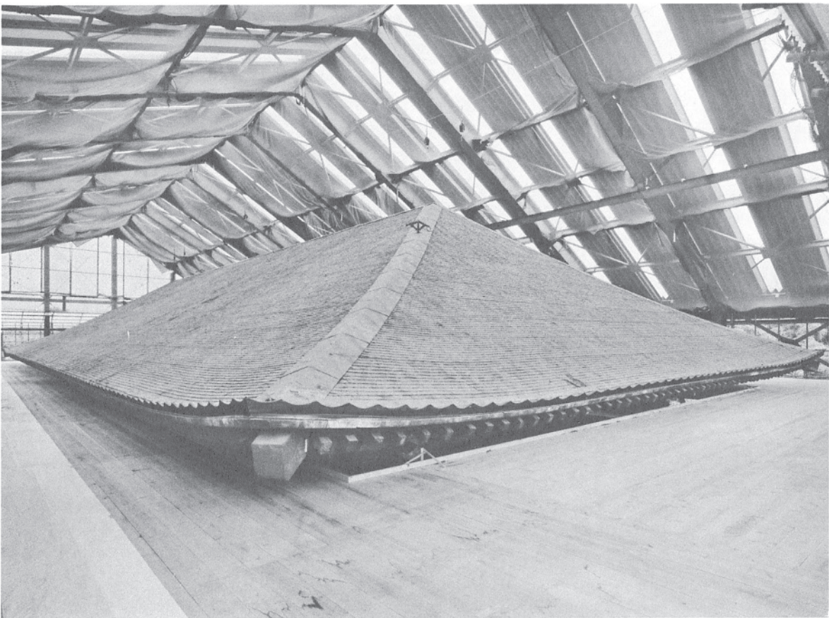
82 北面及び東面の土居葺の状況
