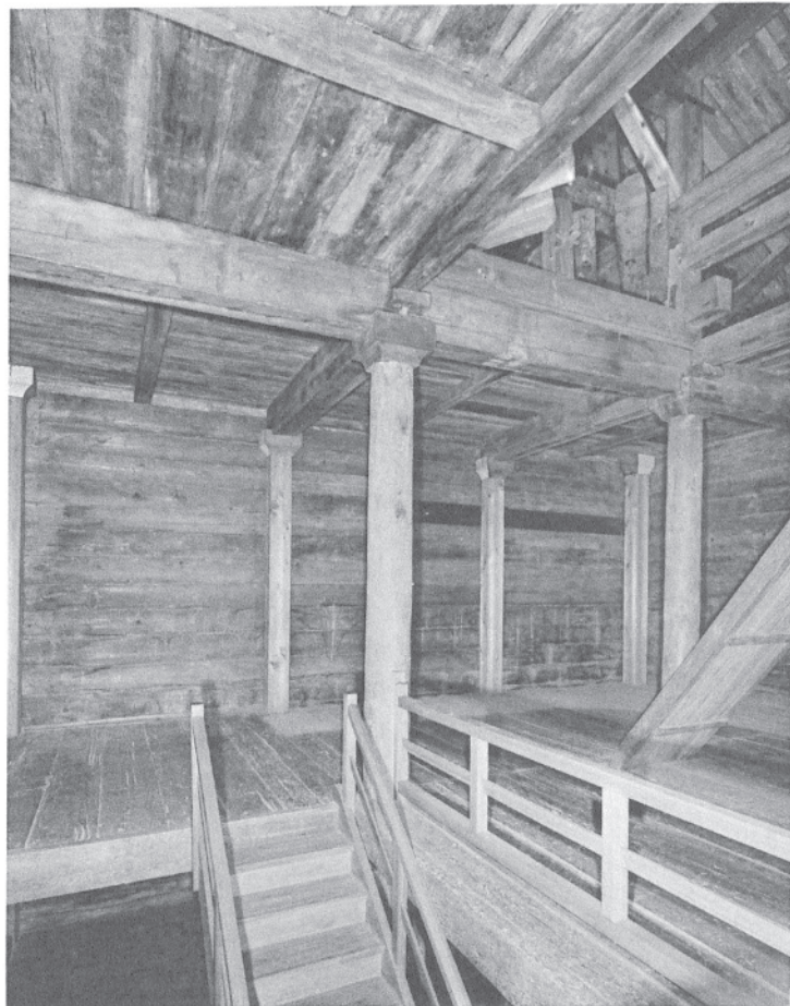
92 ガラス戸付陳列棚解体後の南倉二階南面 東北より見る。
