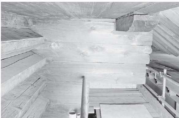
図133 丸桁を受ける三段校木の垂下
