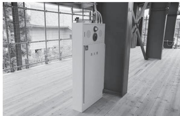
図30 素屋根内消火栓設備
