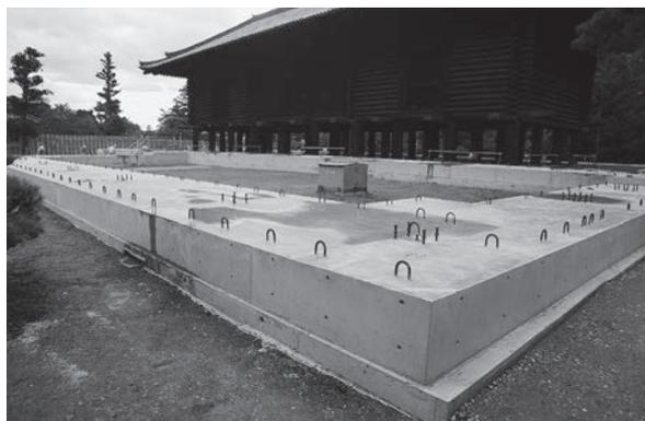
図24 素屋根鉄筋コンクリート基礎脱型
