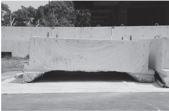
図42 ワイヤソーでの切断面
