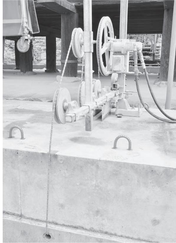
図40 素屋根基礎切断のワイヤソー
