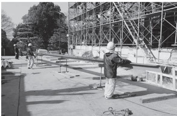
図29 製作した屋根折板
