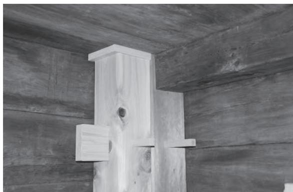
図48 大正期の内部柱に支持柱を取り付けたところ
