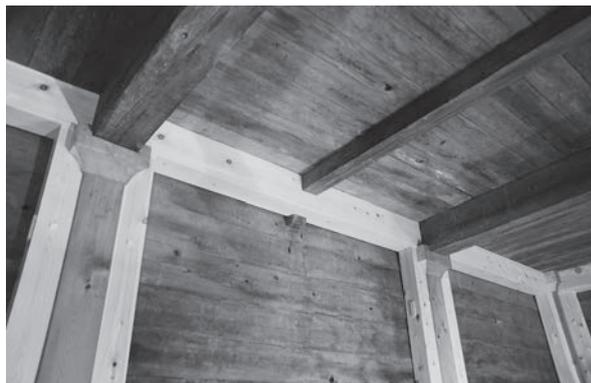
図49 二階の敷桁受と支持柱
