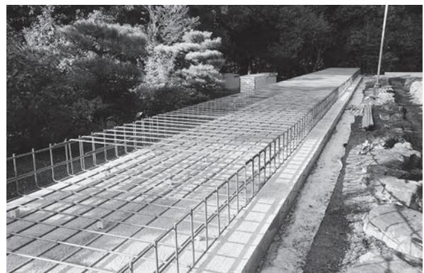
図22 素屋根鉄筋コンクリート基礎配筋
