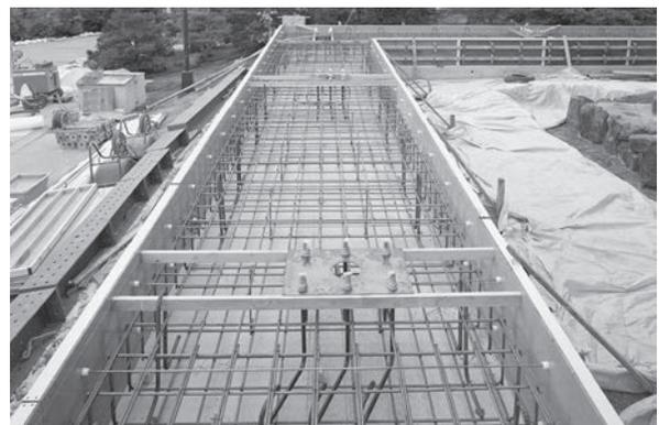
図23 素屋根鉄筋コンクリート基礎の柱アンカー
