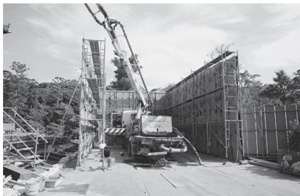
図25 コンクリートミキサー車の防音対策
