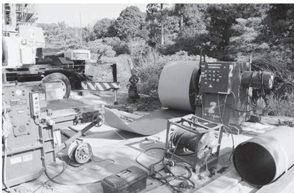
図28 素屋根屋根折板現場製作
