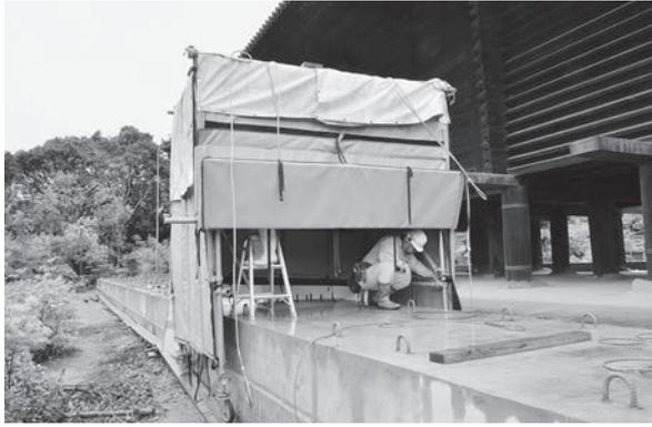
図41 ワイヤソーの切削粉飛散防止と防音対策
