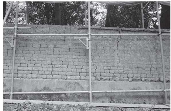
図277 日干し煉瓦積の状況
