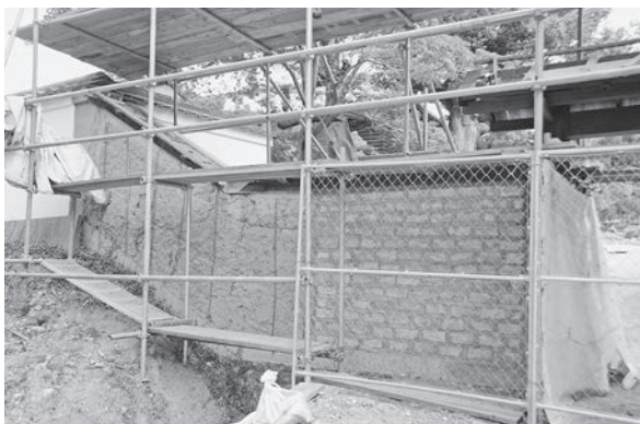
図253 壁下地の乾燥状況
