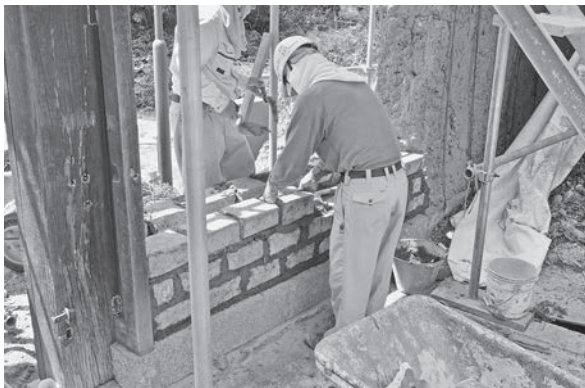
図252 日干し煉瓦の積み上げ
