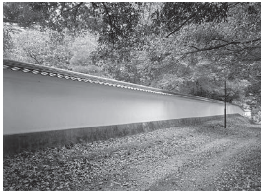
図262 竣工した北土塀（北側東端）
