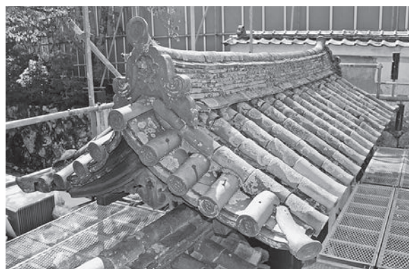
図254 屋根瓦に付着した苔
