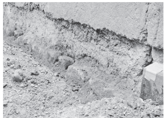
図283 土塀の基礎玉石
