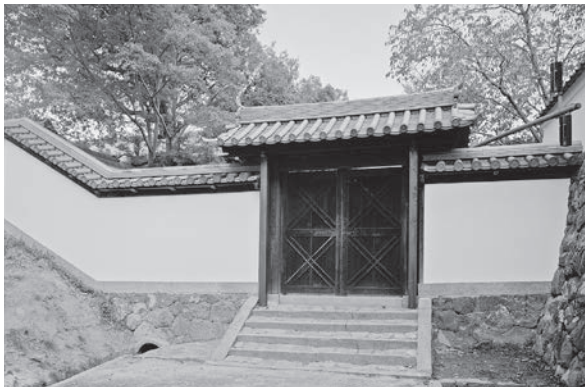
図249 竣工した宝庫西門（西面）
