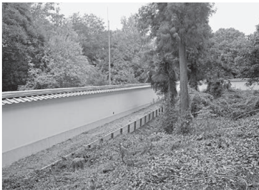
図264 竣工した北土塀と西土塀（西北隅内側）
