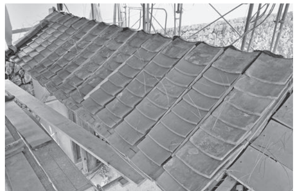
図251 平葺の施工
