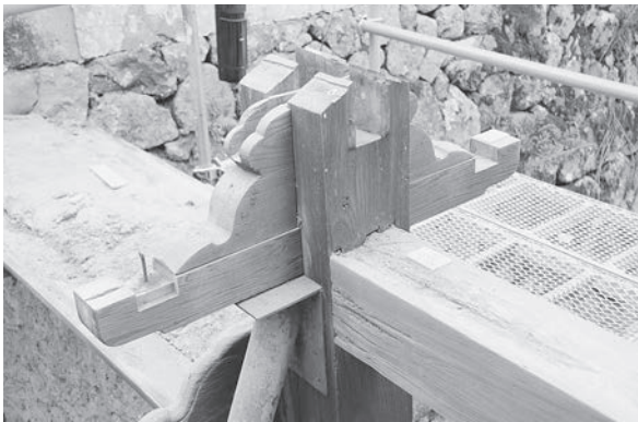
図261 宝庫西門柱頂部の納まり
