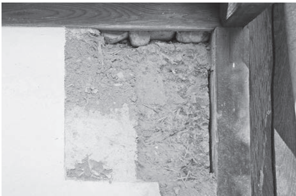
図260 壁の施工状況と載せられていた小石
