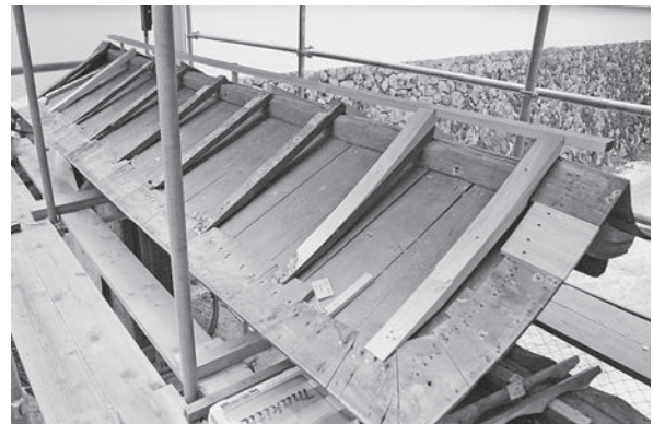
図250 野垂木の施工
