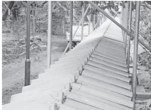
図267 椽瓦葺の状況（北面）
