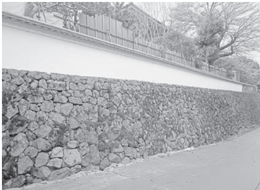
図265 竣工した西宝庫北側土塀（北面）
