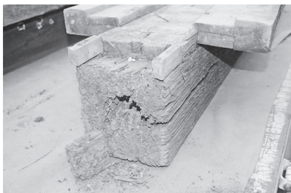
図257 柱根の破損
