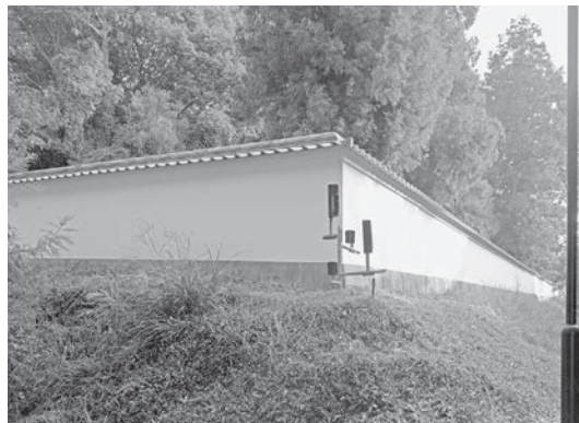
図263 竣工した北土塀と西土塀（西北隅外側）
