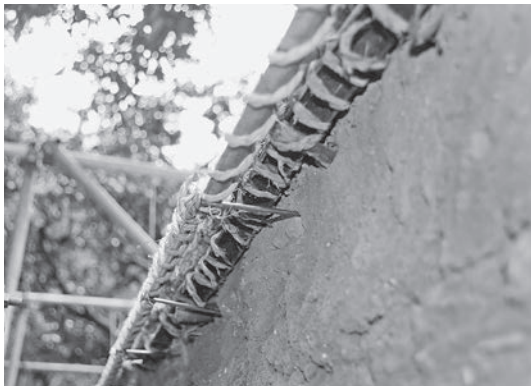
図269 鉢巻の下地となる縄巻竹取り付け
