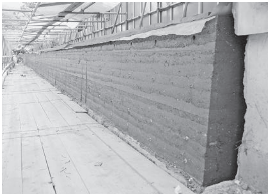
図270 版築による躯体（西宝庫北側土塀）
