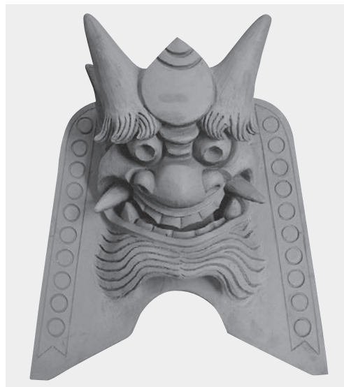
図246 東北一の鬼瓦に残る痕跡 珠文が途中で切れ、左側一番下の珠文を切るように罫引線がある。また、中央の股お練りの両脇には勾配の違う面があり、これがもともと二の鬼瓦であった足の付け根に当たることがわかった。右に復原した鬼瓦を示す。
