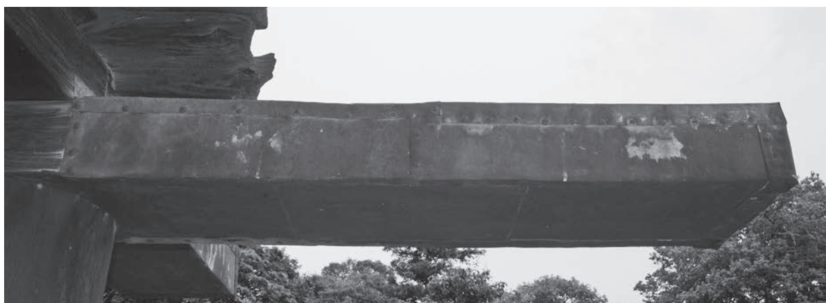
図231 台輪鼻先銅板包み
