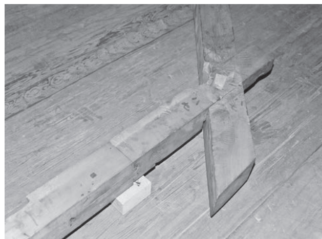
図240 根太掛隅部の継手・仕口
