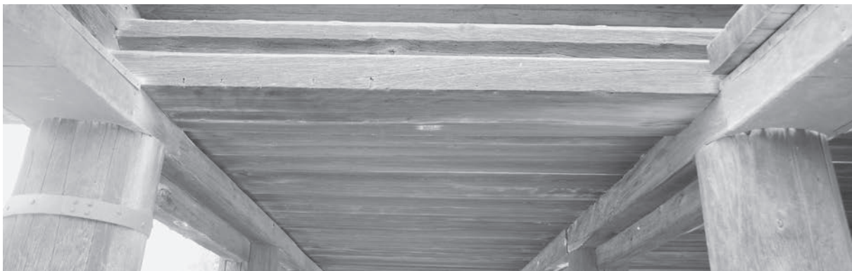
胴差なし（い九・い十間、東より見る）
