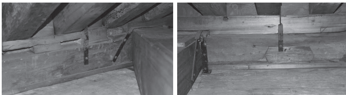
図230 丸桁に残る天保桔木の痕跡
