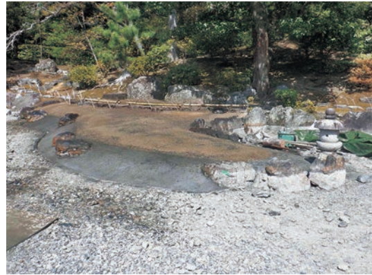
図22 地盤施工完了
