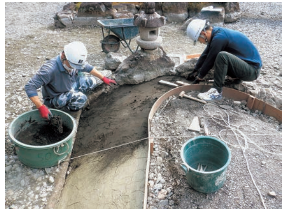
図19 固化材混合土施工状況
