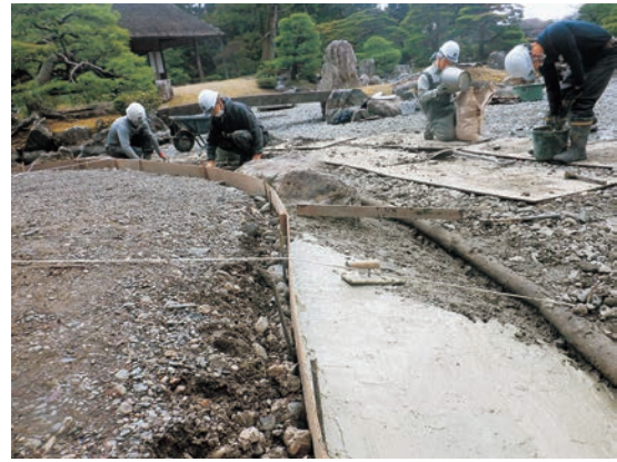
図17 砂利粘土充填・敷均し
