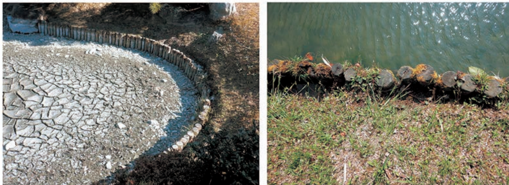
図2 改修前の乱杭護岸
