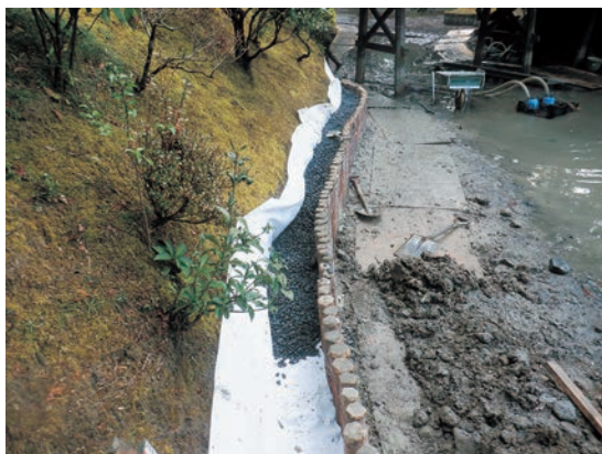
図6 裏込砂利埋戻し
