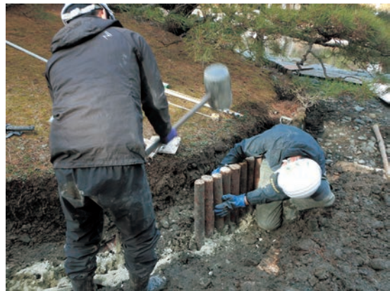
図5 乱杭打込み状況
