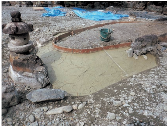
図18 砂利粘土養生完了後
