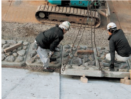
図27 斜面下段作業状況
