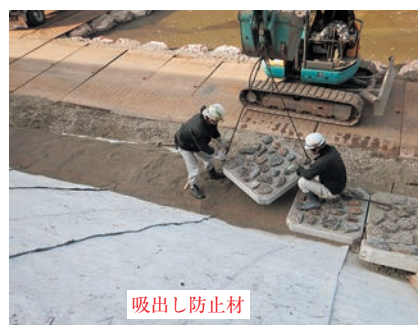
図26 斜面下部作業
