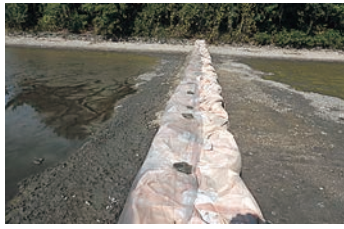
図15 土のうによる仮締切
