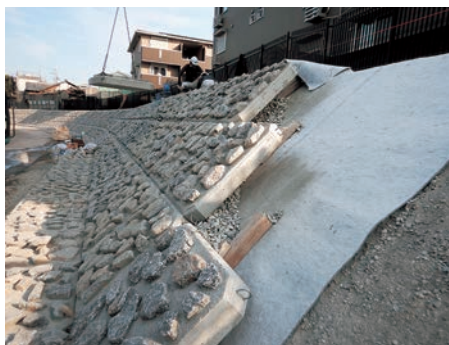
図29 斜面作業状況
