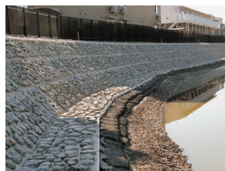
図32 外堤護岸（完了直後）
