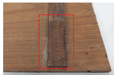
図5 斜めに削り取られた背面柱
