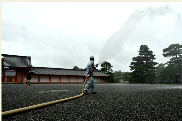
消火設備動作確認
