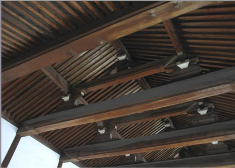
化粧屋根裏天井(京都御所:紫宸殿)
