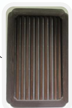
桂離宮・園林堂正面左にある連子窓
