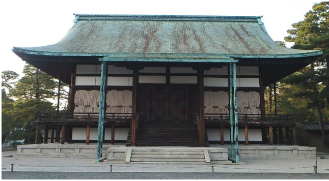
春興殿 (施工前)
