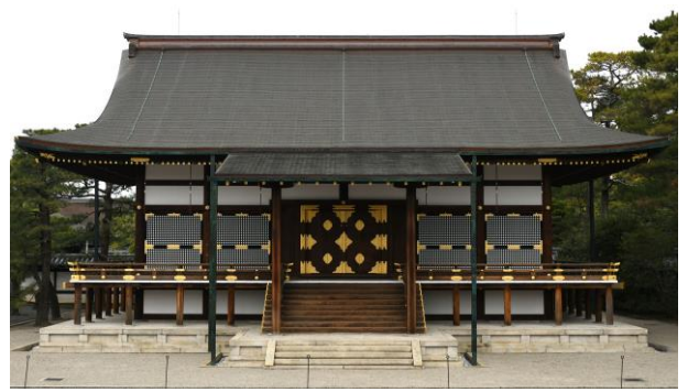
春興殿 (施工後)
