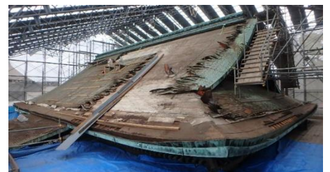
② 銅板葺の解体
