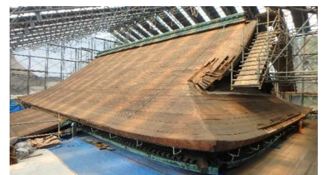
③ 屋根葺材撤去後、野地板の状態
