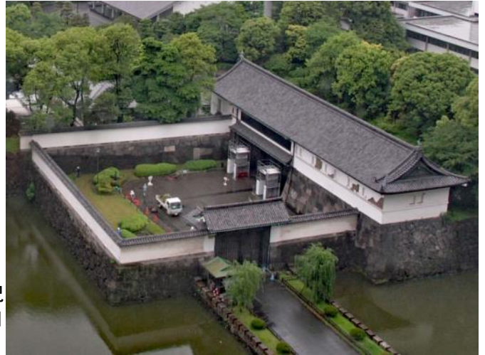
大手門被災状況 (平成23年6月17日 宮内庁管理部撮影)
