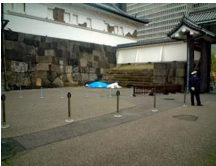
大手門被災状況 (平成23年4月9日 宮内庁管理部撮影)
