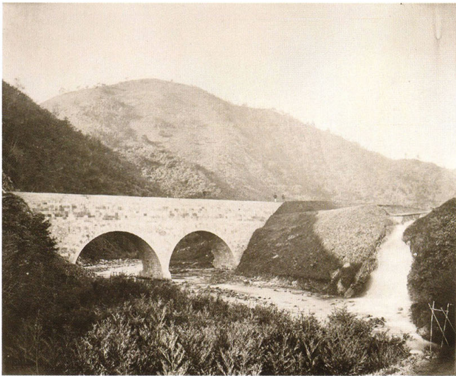
30-4 同第十一図 熱海疏水橋
