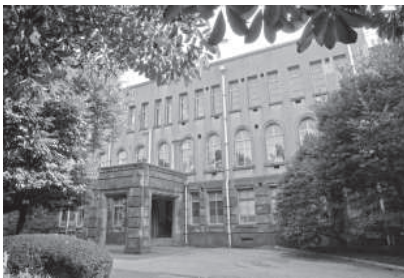
昭和2年完成の旧図書寮庁舎
