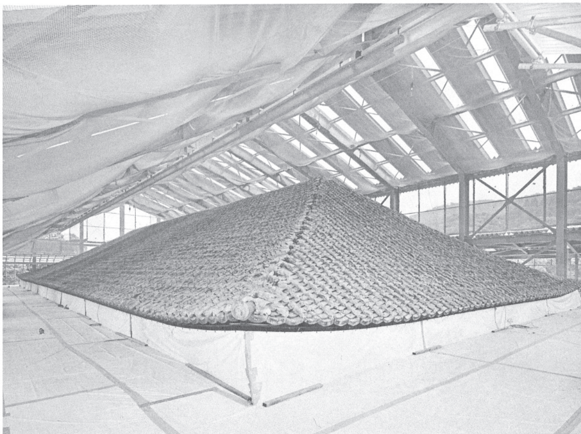
69 南面及び西面の丸瓦葺土の状況 西南より見る。
