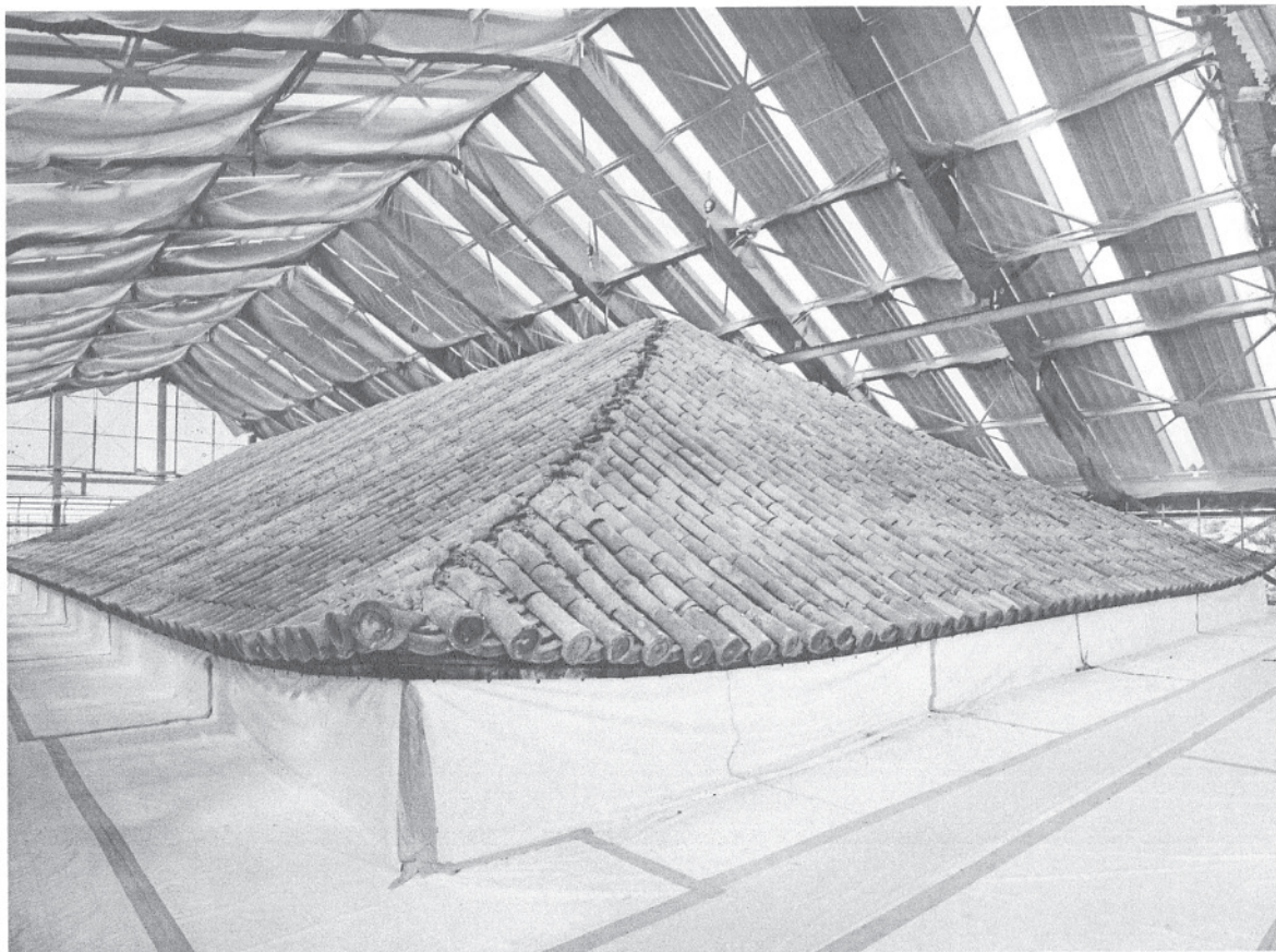
65 東面及び北面の棟積解体後の状況 東北より見る。
