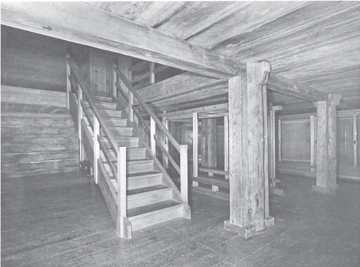
32 修理前南倉内部一階南面及び西面 東北より見る。階段は大正修理後のもので、古い梯子段は取り外され、小屋裏に保管されていた。
