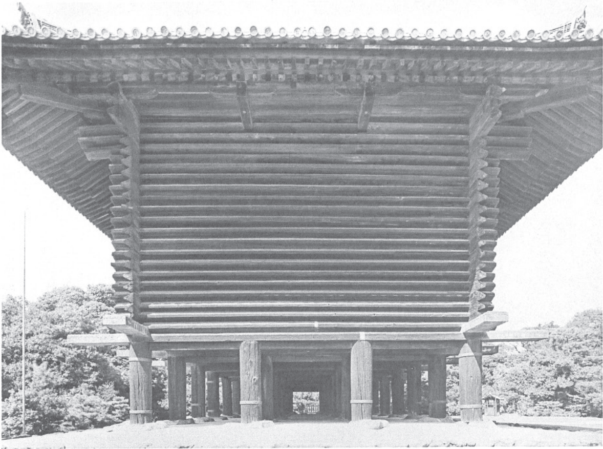
27 修理前南倉南面詳細 南倉南面の修理前の詳細。
