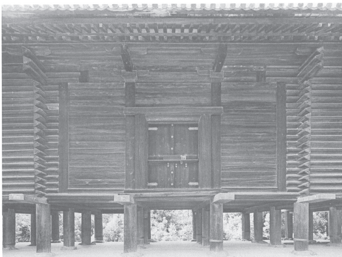
29 修理前中倉東面詳細 中倉東面の修理前の詳細。
