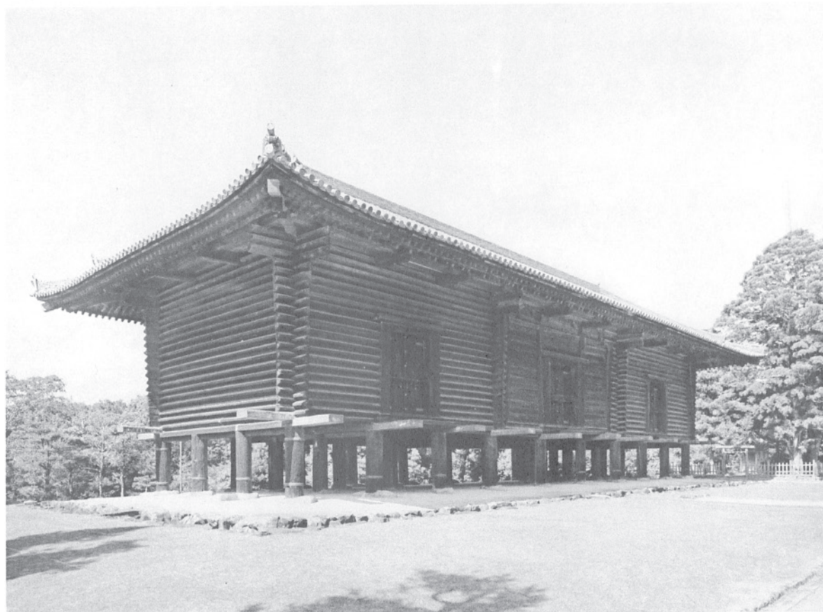
22 修理前正倉正側面（東面及び南面） 南倉手前からの修理前の状況。南面の軒が少し波打って見える。
