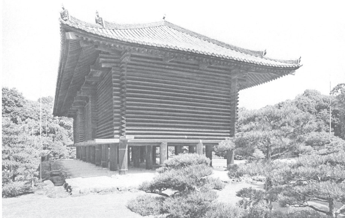
25 修理前正倉側面（南面） 西南から見た南面の修理前の状況。
