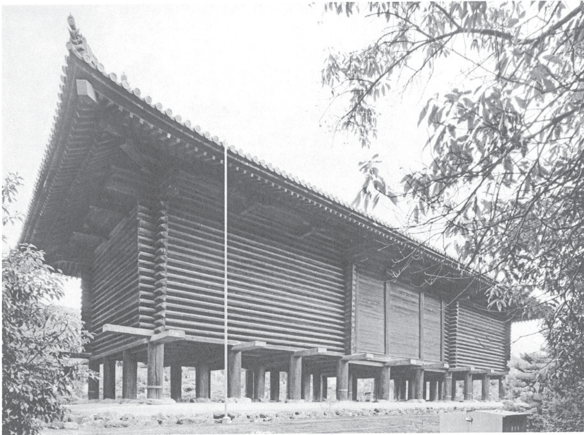
23 修理前正倉背側面（西面及び北面） 北倉奥からの修理前の状況。
