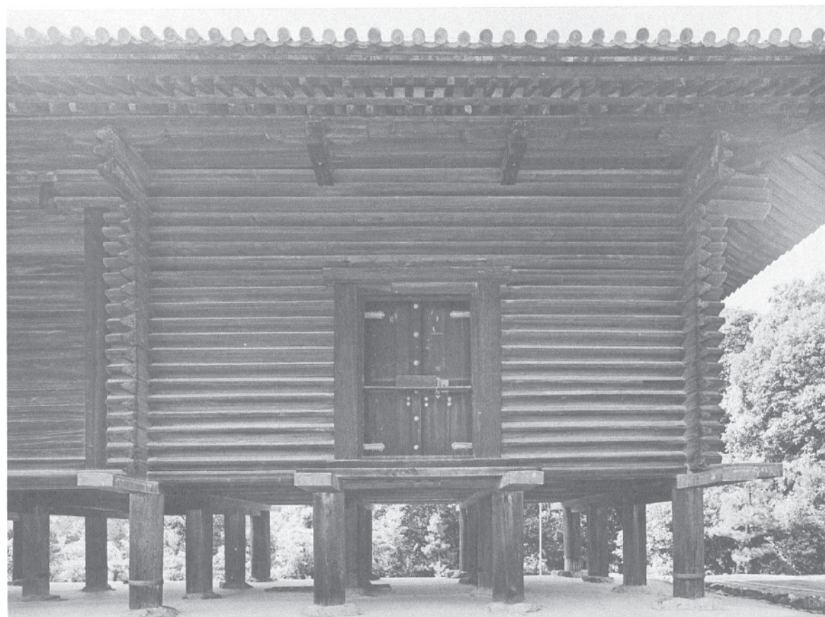
30 修理前北倉東面詳細 北倉東面の修理前の詳細。
