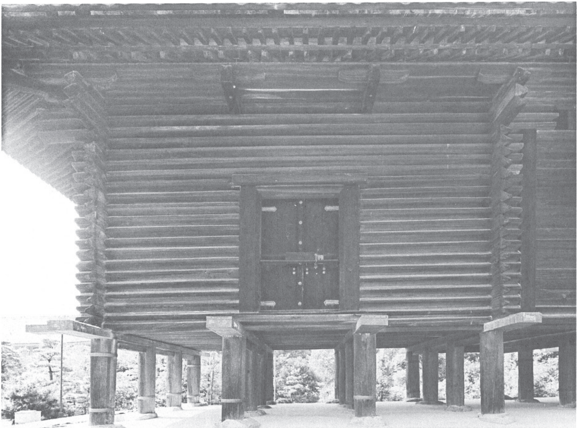
28 修理前南倉東面詳細 南倉東面の修理前の詳細。
