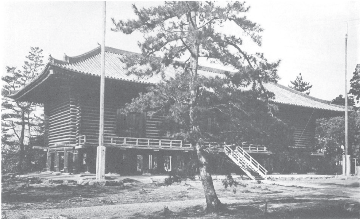
214 大正修理の竣工正側面（東面及び南面） 「第五八号 宝庫修繕竣工東側及南妻実況」。東面には床と階段が設けられ、宝物を搬入する用意がされている。正倉東面に見える柱状のものは避雷針で、先に突針が見える。
