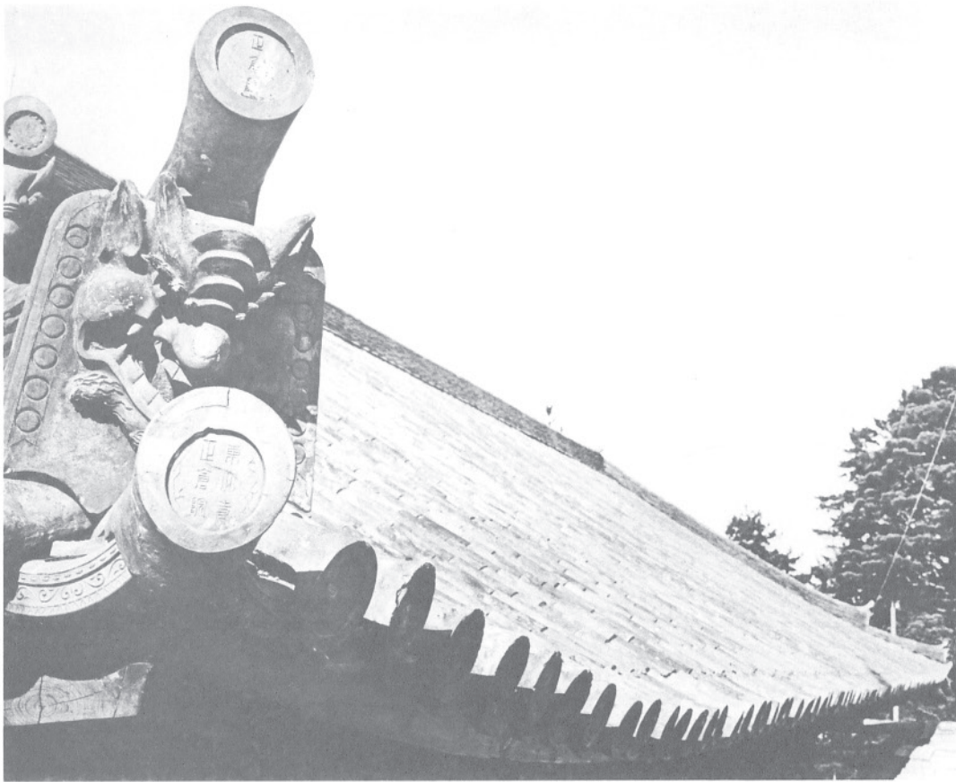
211 大正修理時の東面本瓦葺完了
