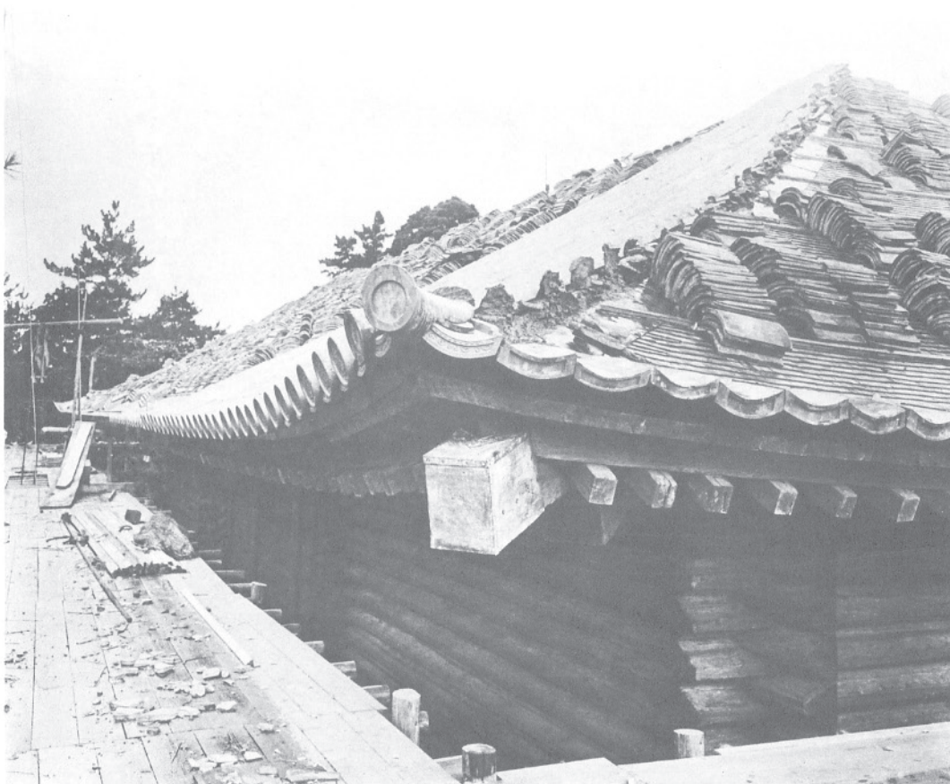
209 大正修理時の本瓦葺施工中
