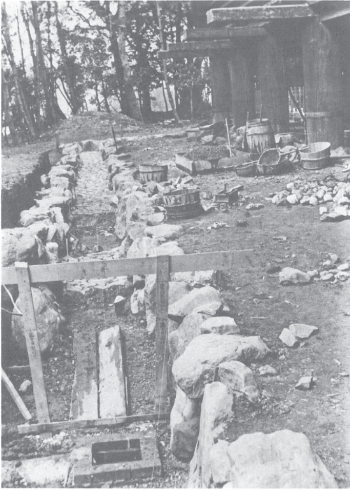
213 大正修理時の西側雨落溝施工中 「第五七号 宝庫西側雨落下水溝縁石積方中現況」。奥から溝底に石敷が施工されている。
