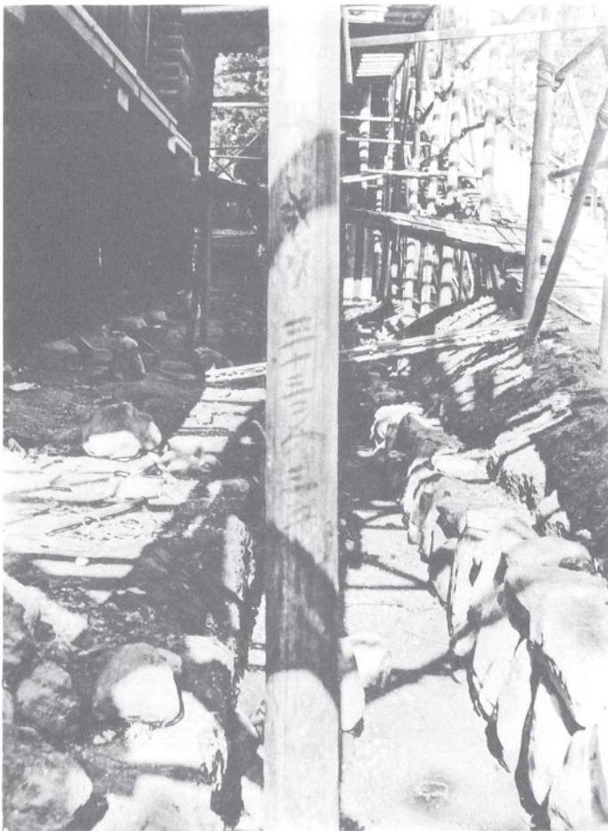
212 大正修理時の雨落溝施工中
