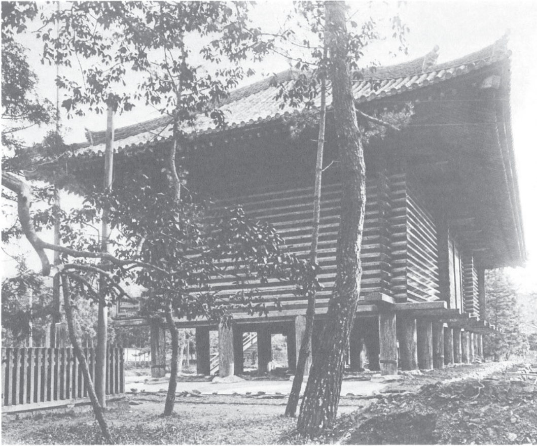
215 大正修理の竣工背側面（西面及び北面） 「第五九号 宝庫修繕竣工西側及北妻実況」。竣工状況を北側の杉本神社西側から見たもの。
