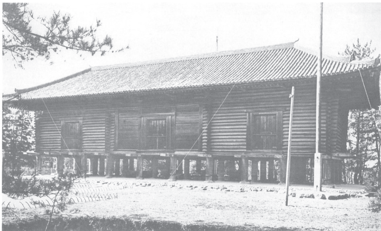
217 大正修理の竣工正面（東面）
