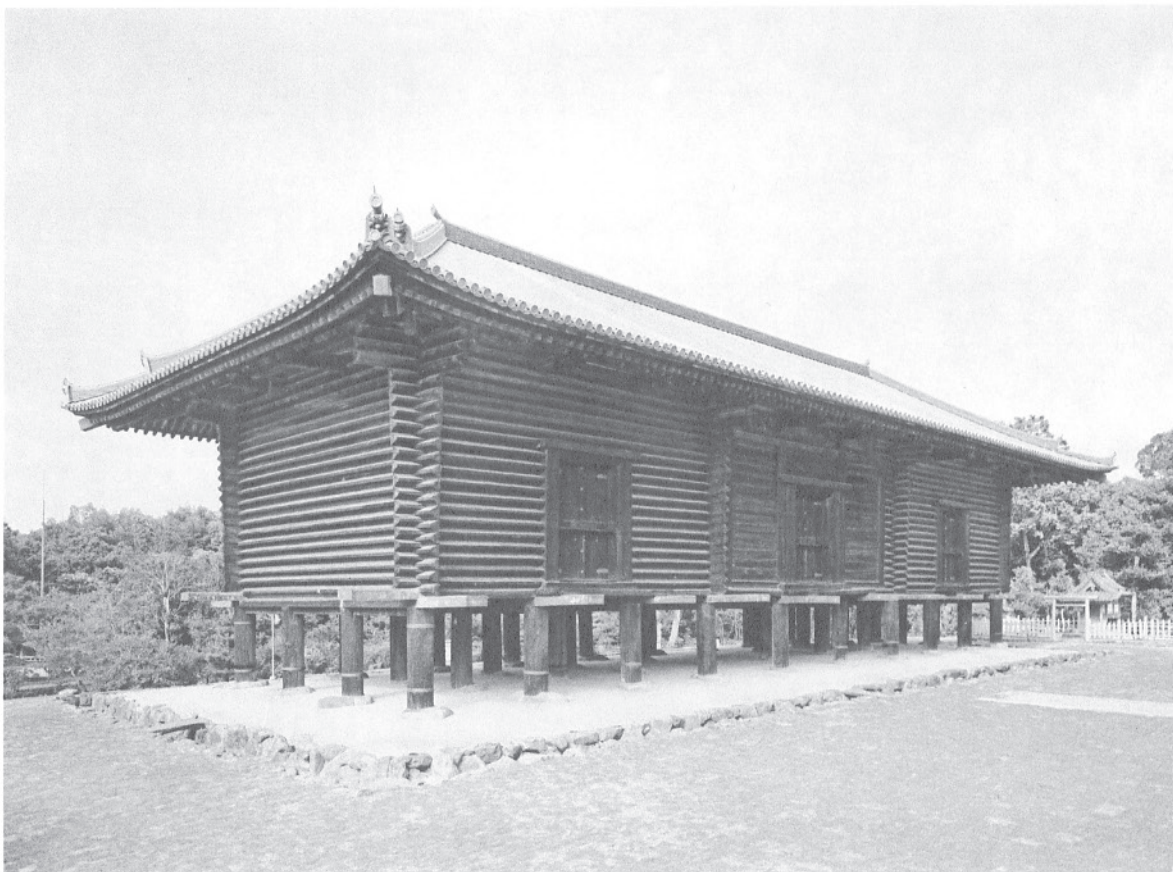
2 竣工正倉正側面（東面及び南面）
