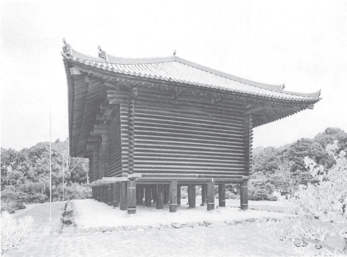
5 竣工正倉側面（南面） 南面の屋根には、中央に鎌倉時代の再用瓦を、両脇には天平期の再用瓦を用いて葺き上げた。
