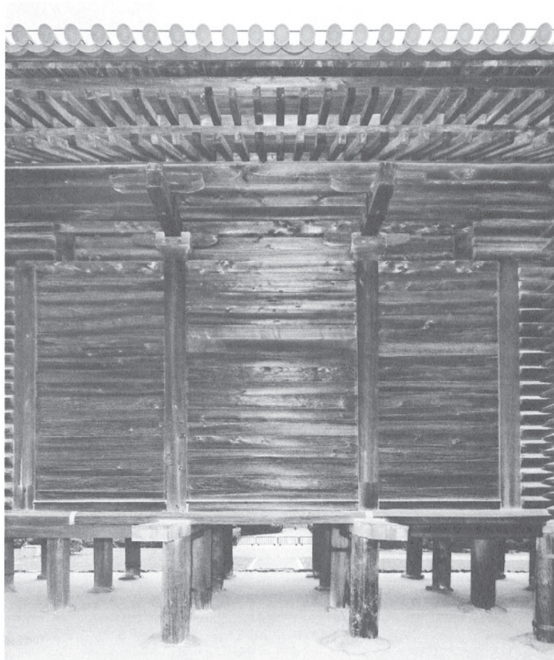
8 竣工中倉西面詳細 中倉西面の竣工の詳細。
