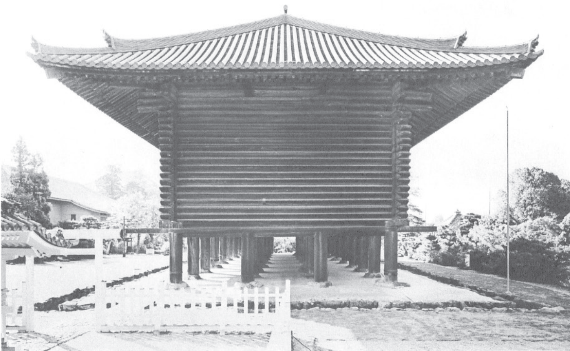
6 竣工正倉側面（北面） 杉本神社の西側から見た北面の竣工の状況。北面の屋根には、現代製法で作った補足瓦を葺いた。
