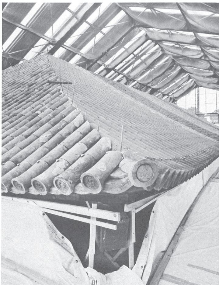
117 東南隅の丸瓦葺き上げ時の状態
