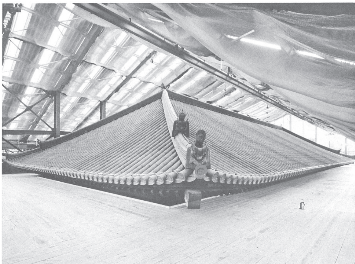
126 北面及び西面の本瓦葺き上がり 西北より見る。北面及び西面は今回の修理で製作した現代製法の補足瓦で葺き上げた。
