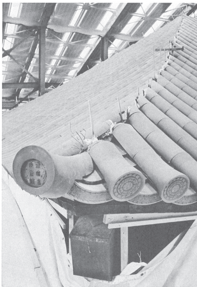
118 西北隅の丸瓦葺き上げ時の状態
