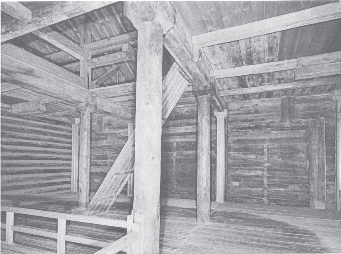
97 ガラス戸付陳列棚解体後の中倉二階西面及び南面 東北より見る。北倉からかかる妻梁にも南倉からかかる妻梁にも、その先端に丸桁があった仕口の痕跡は見られないことから、正倉が「当初は二棟であった」という説は否定される。
