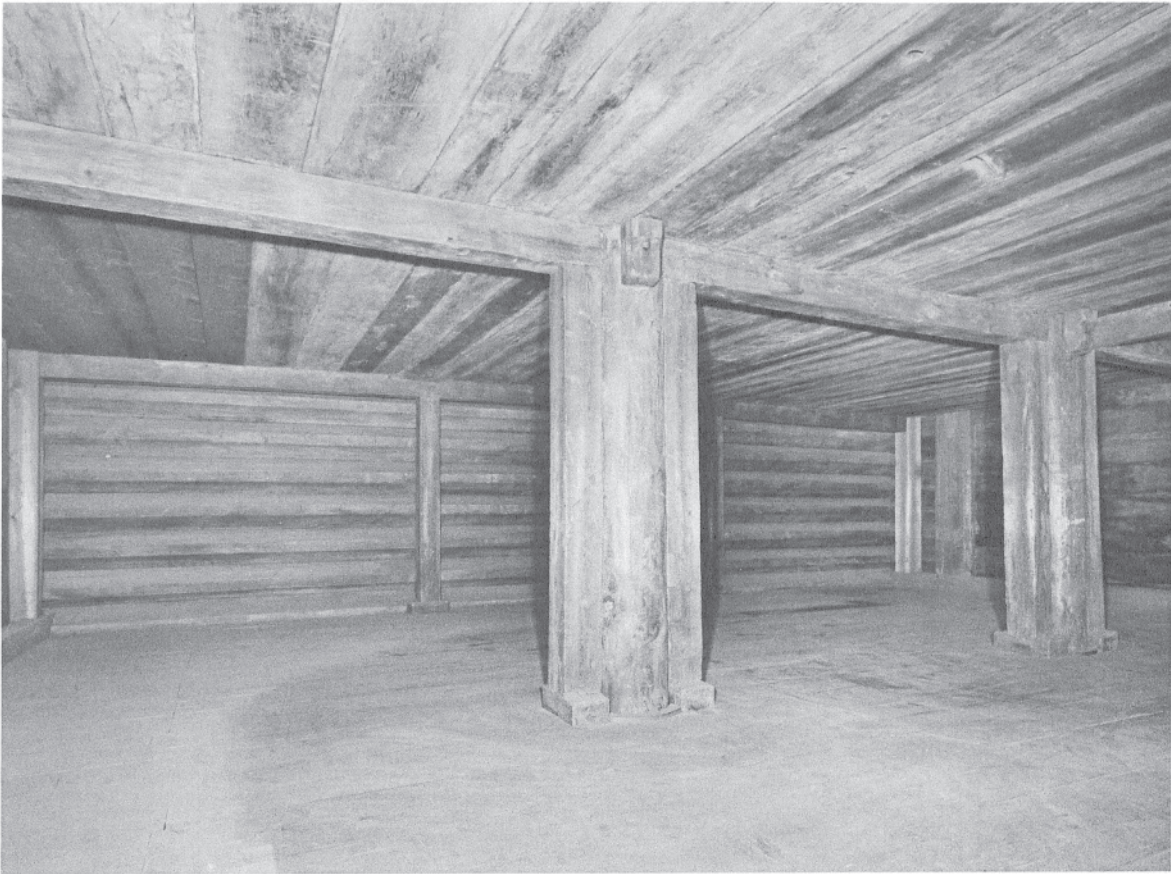
93 ガラス戸付陳列棚解体後の中倉一階北面 西南より見る。北倉南面の校木の外側が見えている。校木前の両端の柱は大正修理時のものであるが、中間のものは当初あるいは創建後かなり早い時期に入れられたものである。
