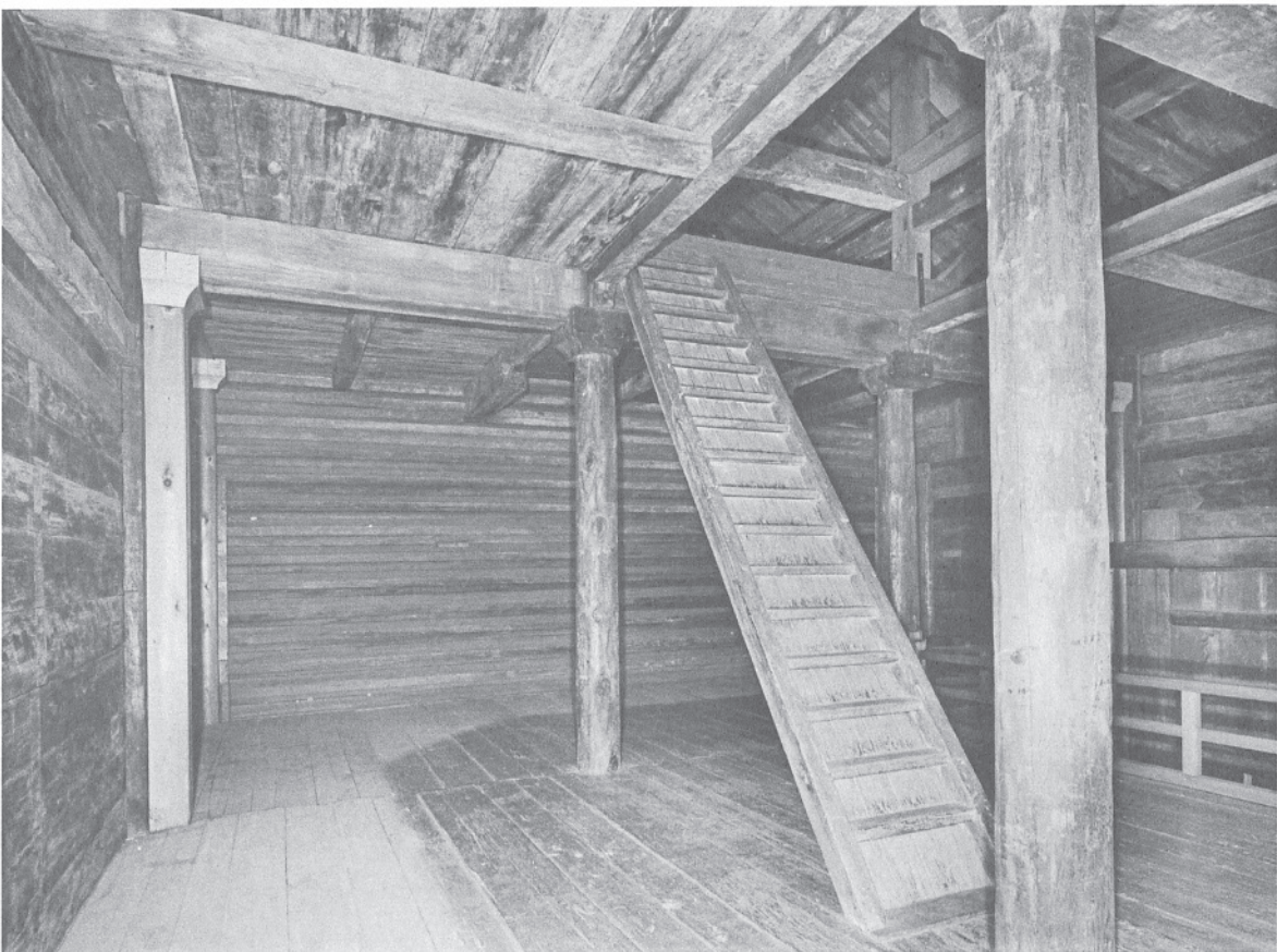
98 ガラス戸付陳列棚解体後の中倉二階北面 西南より見る。
