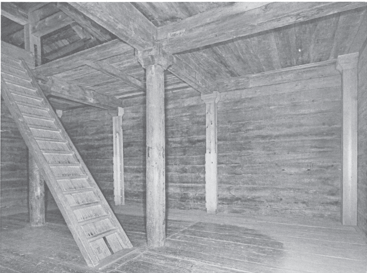
104 ガラス戸付陳列棚解体後の北倉二階西面 東北より見る。
