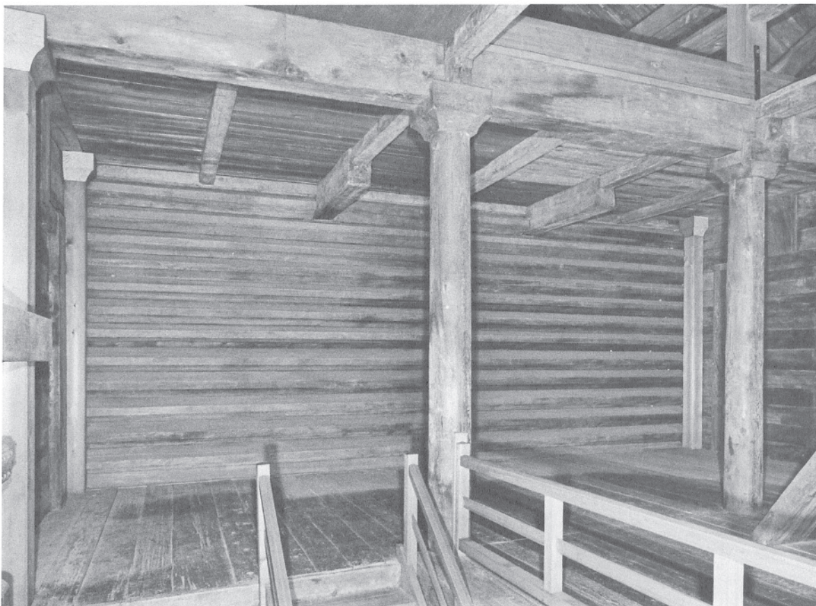
96 ガラス戸付陳列棚解体後の中倉二階南面 東北より見る。南倉大梁から中倉側にかけた妻梁は、中倉の大梁までは届かず、途中で途切れる様子がわかる。
