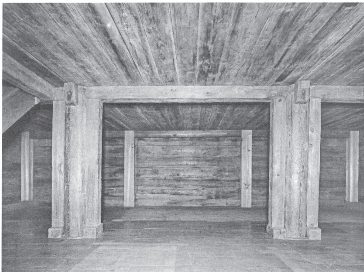
99 ガラス戸付陳列棚解体後の北倉一階南面 北より見る。
