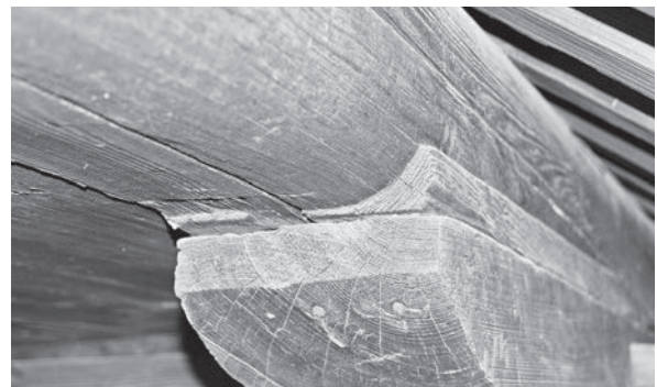
図141 丸桁に残る鑿打ち痕跡 北面は通り（北倉）舟肘木の東方。
