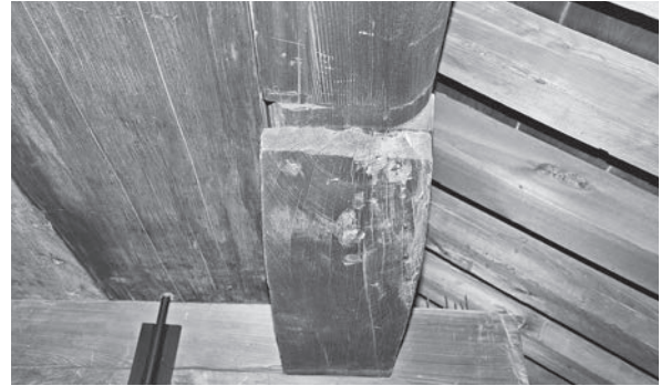
図140 丸桁内側にも丸面が取られている例 西面八通り（南倉）舟肘木の北方。
