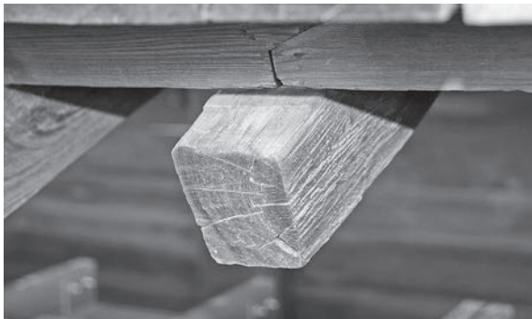
図148 鼻先を切られた当初飛檐垂木 鼻先の風蝕から切られたことが窺える。
