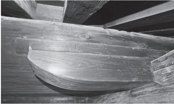
図142 舟肘木造り出しが欠き取られた痕跡 南倉東南隅（い通り）南面西方。
