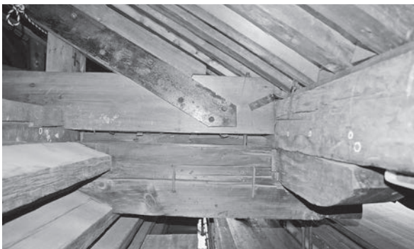
図143 大梁先の部材の取り合い 軒天井板を外したところ。東面二通り（北倉）。
