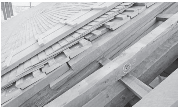
図152 野地の状況 調査のため二重野地は切断して解体した。
