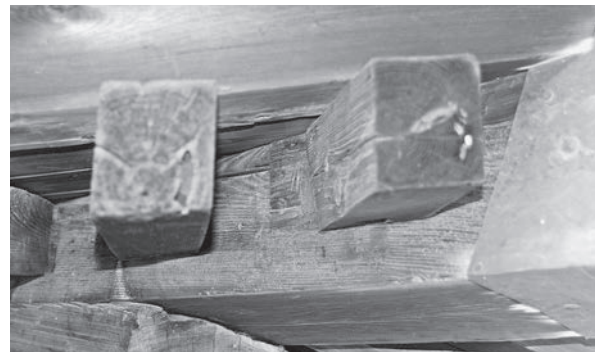
図149 飛檐隅木に残る痕跡の埋木
