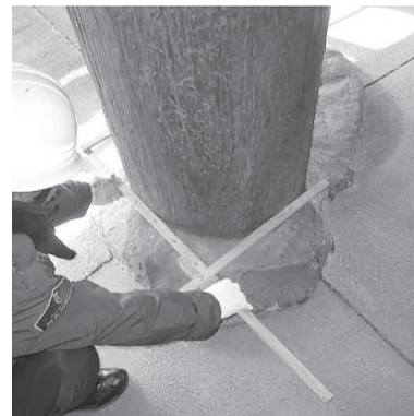
図116 柱有効径の計測の様子
