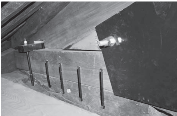
図84 H金物先の鋸補強 隅行の陸梁（上）と隅木受尾垂木を繋いだ。
