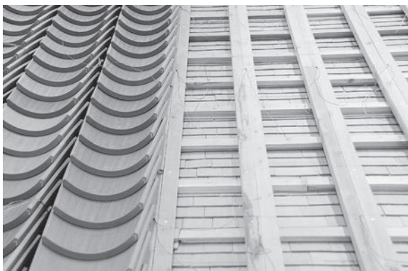
図58 西面空葺の様子
