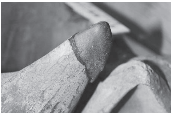
図62 鬼瓦の角の補修
