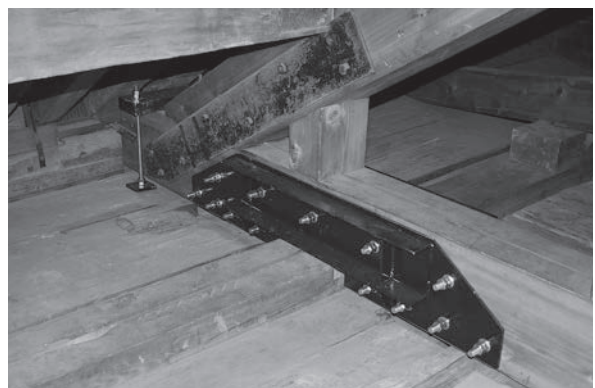
図81 F金物とG金物の吊元 既存の金物は活かした。奥がG金物の吊元。
