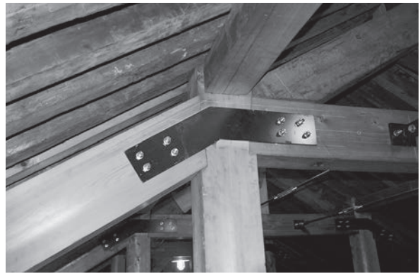
図79 A金物 既存の金物は取り外した。
