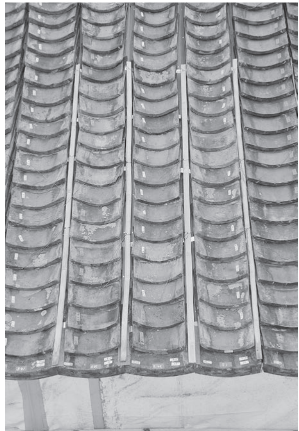
図59 平瓦の間に挿入した割竹
