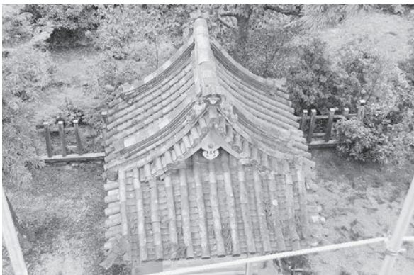
図295 杉伐採直後の屋根の状況
