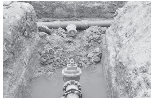
図302 新規ポリエチレン管と切り離した既存管
