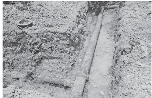
図301 昭和十二年に設置された消火栓配管
