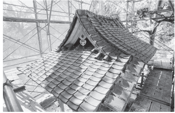
図286 丸瓦解体後の状況
