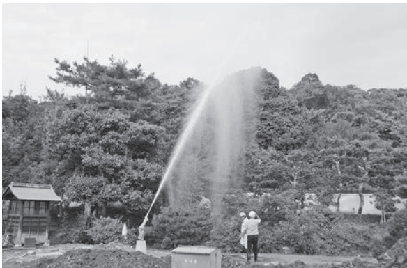
図304 放水銃の送水試験
