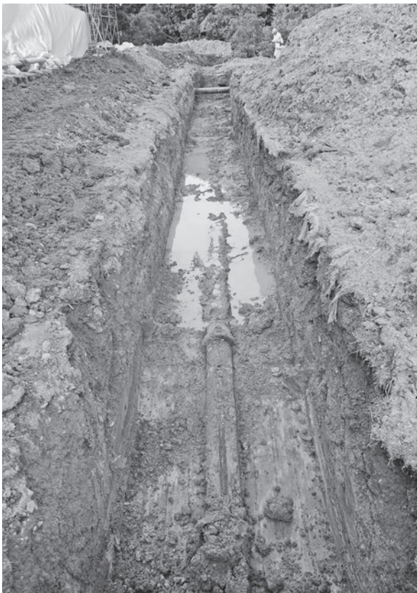
図303 掘削と配管撤去後（奥）の状況
