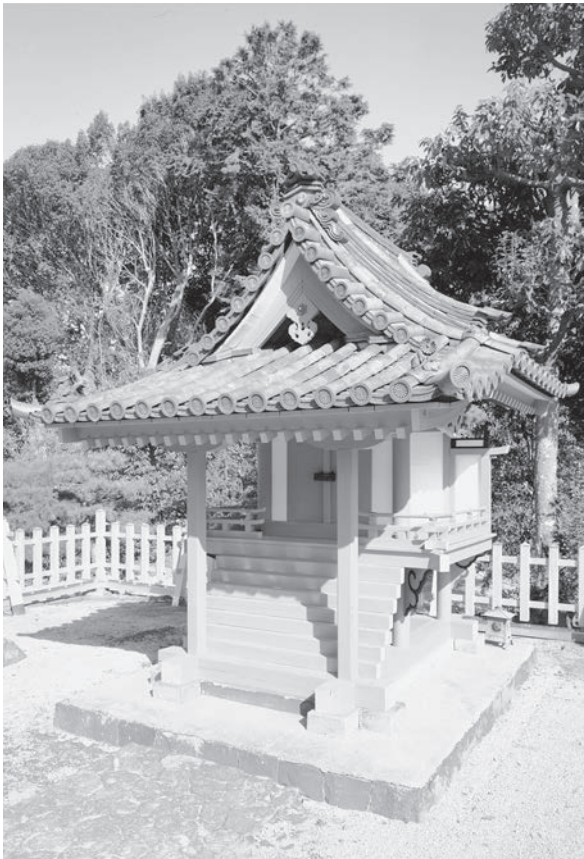
図292 杉本神社竣工正側面（東南面）
