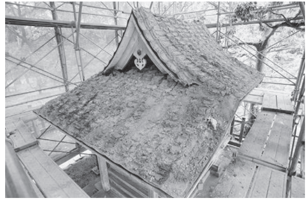
図287 平瓦解体後の状況
