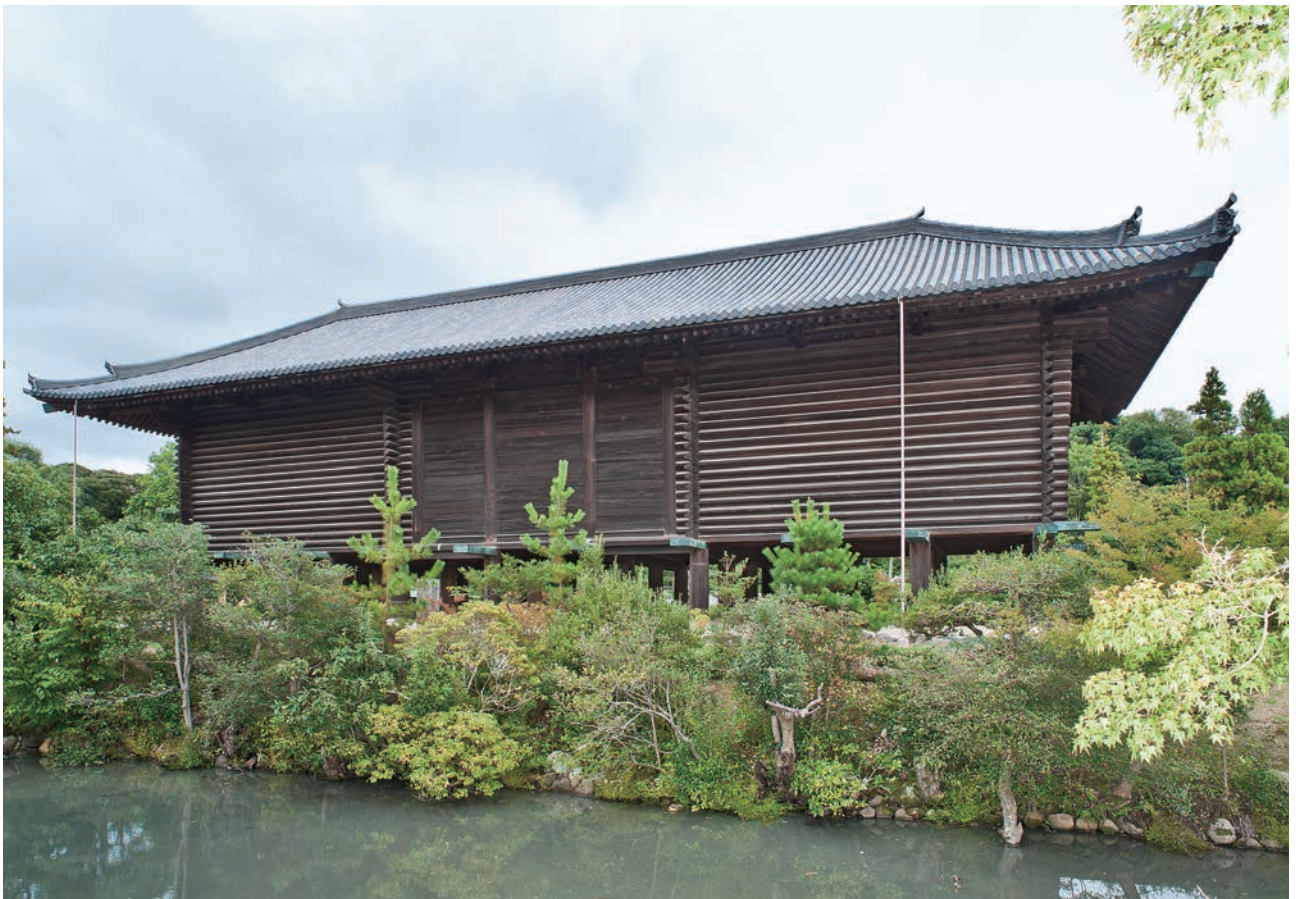
3 竣工背面（西面）
