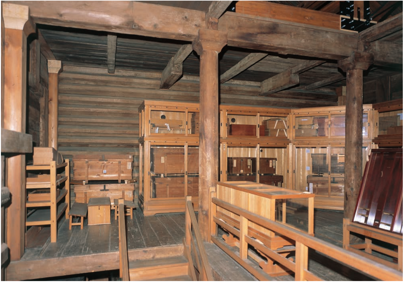
7 竣工中倉内部二階南面 唐櫃等保管の状況
