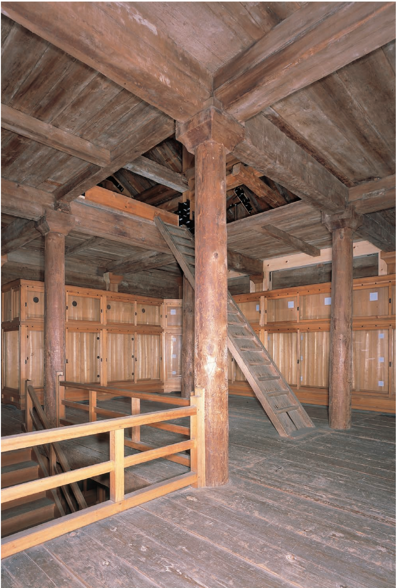
6 竣工北倉内部二階南面及び西面
