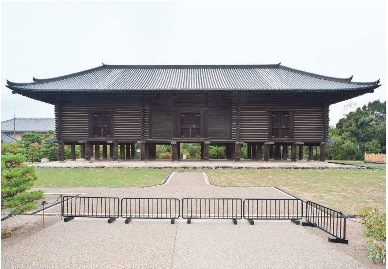
2 竣工正面（東面）
