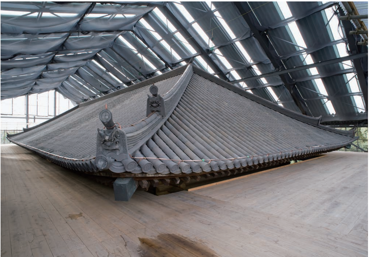
5 北面及び東面本瓦葺完了 東北より見る
