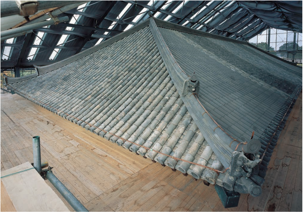
4 南面及び東面本瓦葺完了 東南より俯瞰
