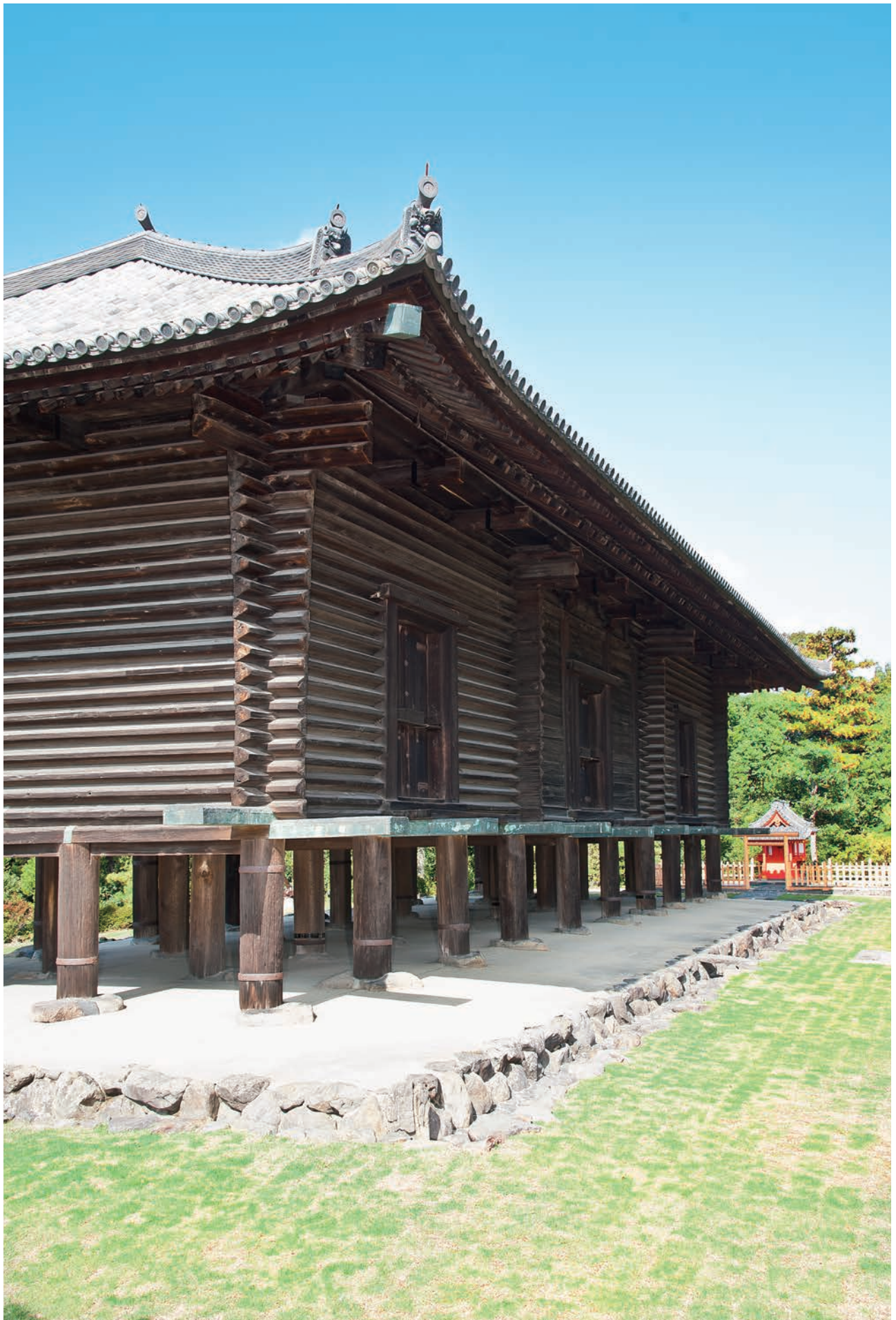
1 竣工正面（東面）見通し
