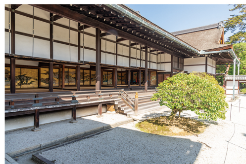
建具を外し内部を公開した様子
