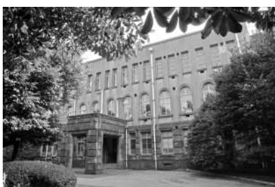
昭和2年完成の旧図書寮庁舎
